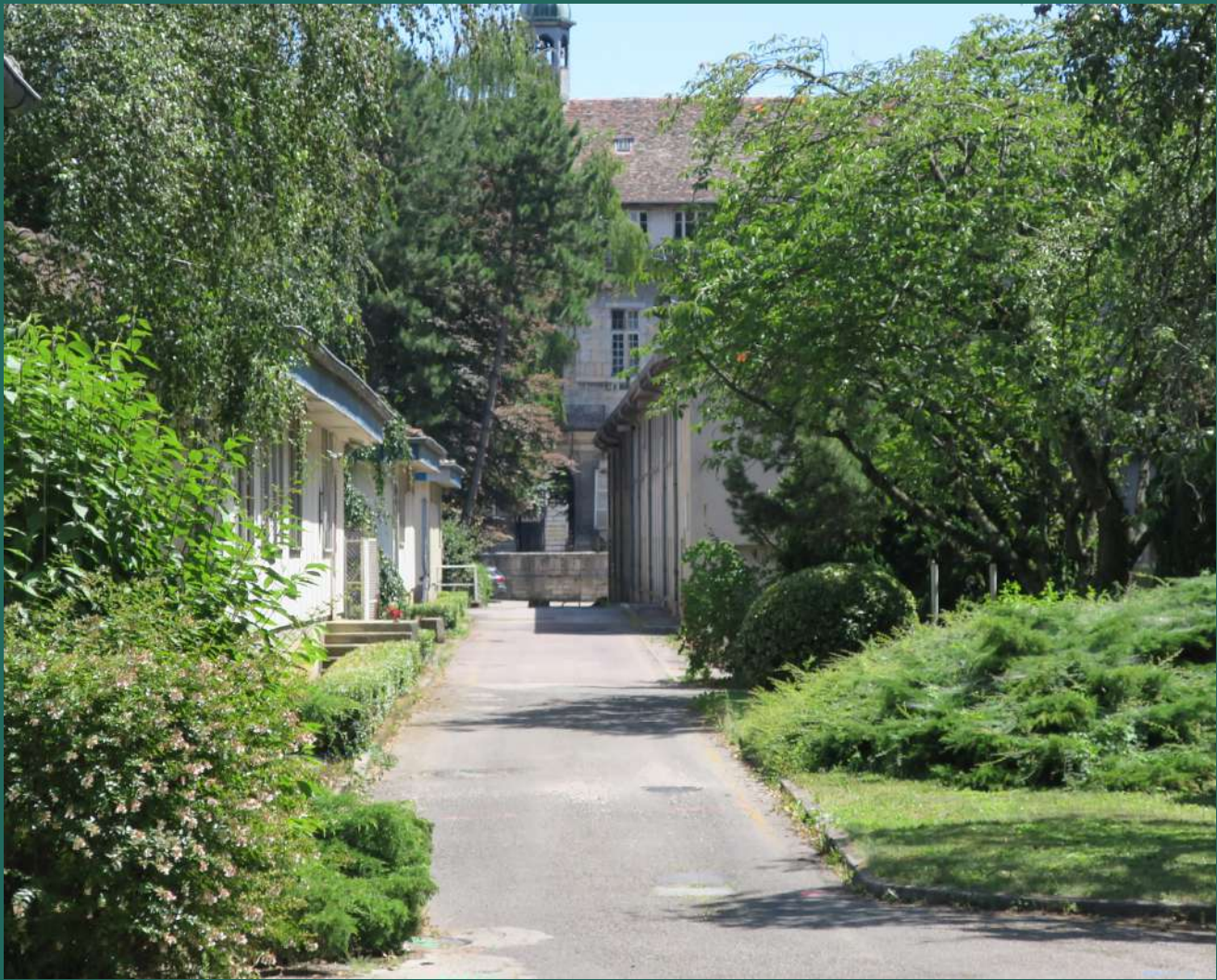
Vue depuis l'espace central Saint-Jacques
