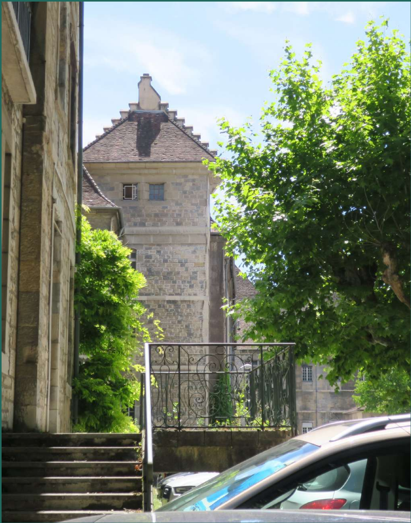
Vue depuis l'espace central Saint-Jacques
