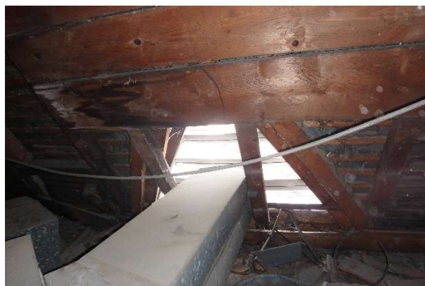
Photo n°20. Saint-Denis : exemple de voliges partiellement favorable car absente au niveau de la zone d'accès (ouverture sous-toiture)
