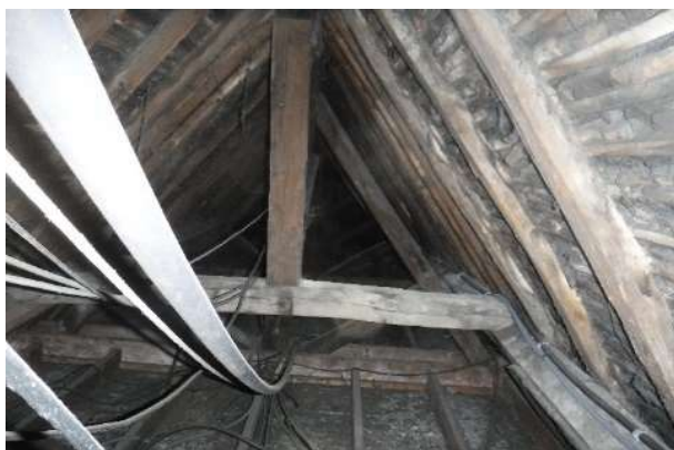
Photo n°19. Combles actuels du bâtiment saint Joseph
