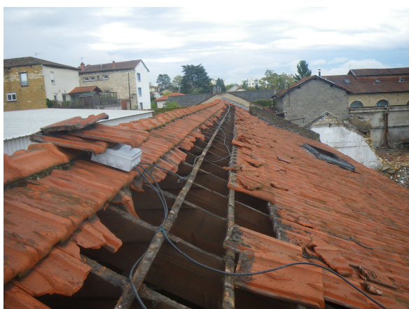
Photo n°14. Démontage de toiture afin d'éviter un retour au gîte
