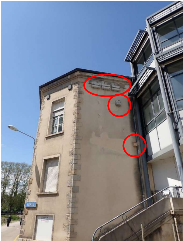
Photo n°32. Nichoirs à démonter et remonter
