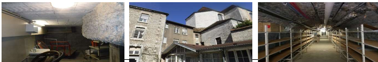
Photo n°16. Exemple de secteurs non favorables aux chauves-souris : sous-sol fermé, bâtiment récent à tuiles plates, sous-sol soumis à un fort dérangement (sous le poste de garde)
