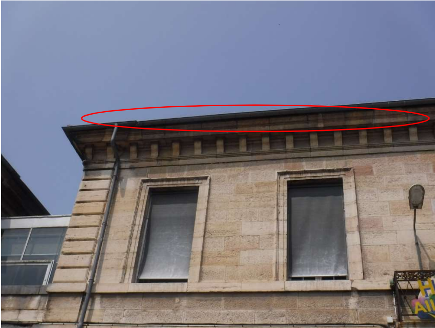
Photo n°8. Site de l'Arsenal nidification probable sous la gouttière en façade Est
