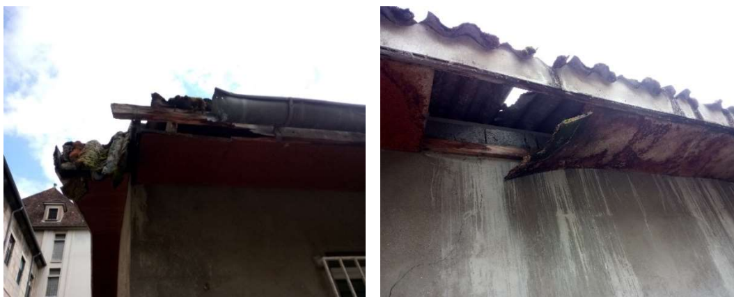
Photo n°15. Accès sous les toits sur des bâtiments récents
