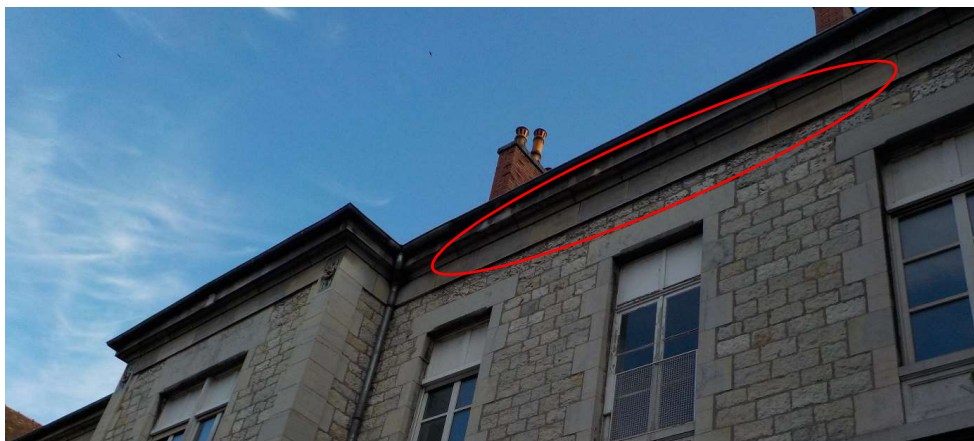
Photo n°4. Espace entre le chéneau et la toiture où se glissent les Martinets pour nicher (bâtiment Bersot)
