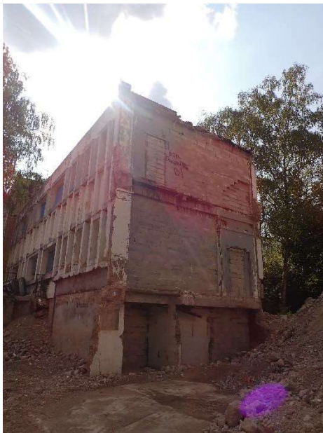
Photo n°26. Zone de jonction en parpaing comprenant des nombreuses anfractuosités
