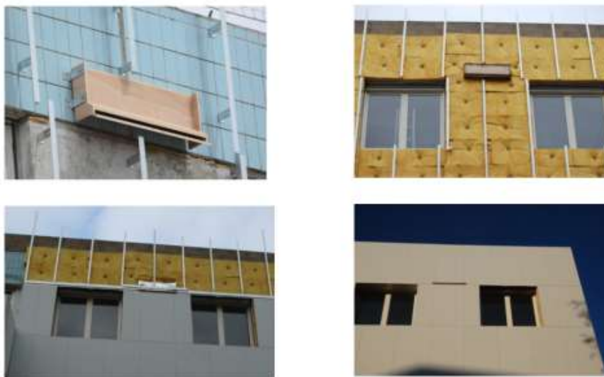
Photo n°21. Exemple de gîtes pour les chiroptères
