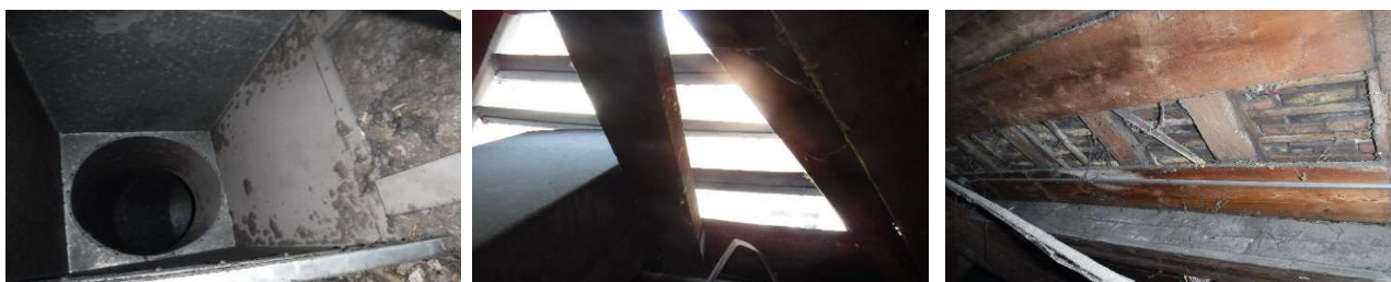
Photo n°11. Combles (Sainte-Anne) avec ouvertures, conduits d'aération, poutres en bois et toiture en tuiles
