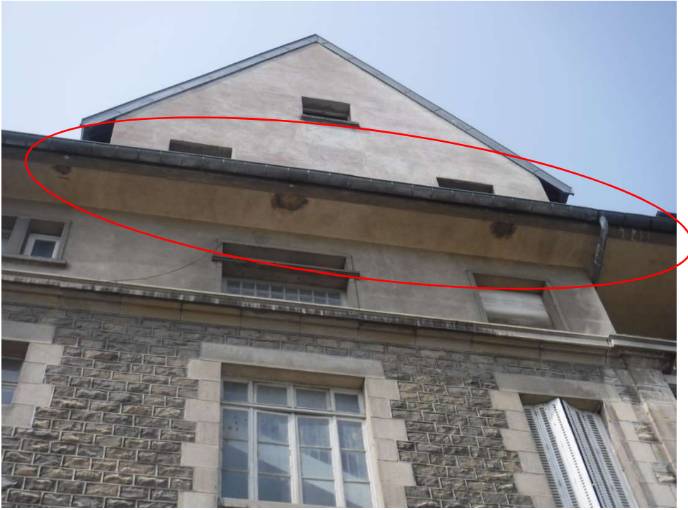
Photo n°6. Bâtiment Ledoux façade Est nidification du Martinet noir sous la gouttière
