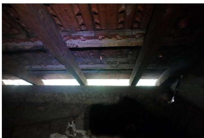
Photo n°17. Exemple d'accès sous-toiture
