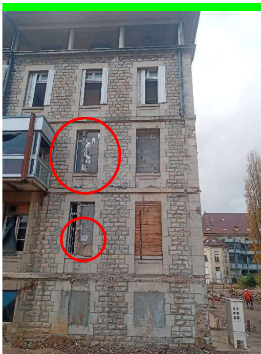
Photo n°30. Parpaings équipés de système anti-retour
