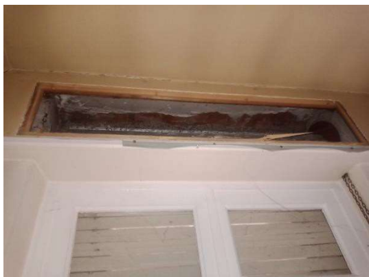
Photo n°29. Façade intérieure démontée
