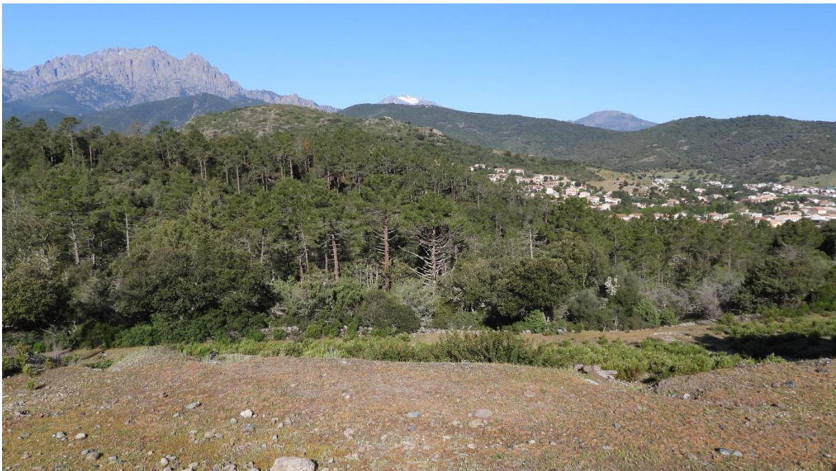
Photo 17. Covisibilité avec le projet depuis la piste d'accès en terre au poste EDF et au projet (source : ENDEMYS)
