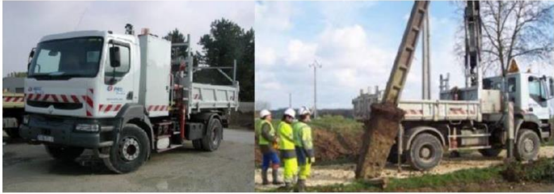
Engins de chantier :
