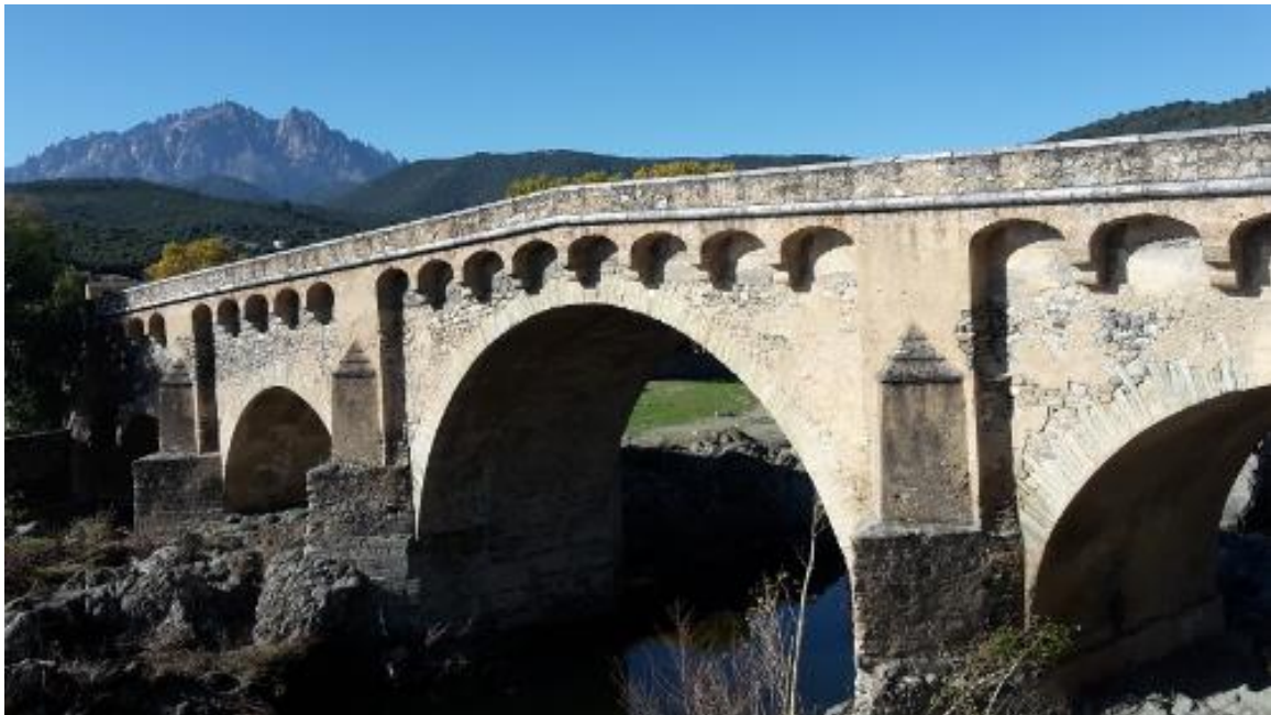
Photo 16. Pont génois de Ponte Leccia (source : ©Office du Tourisme Pasquale Paoli)
