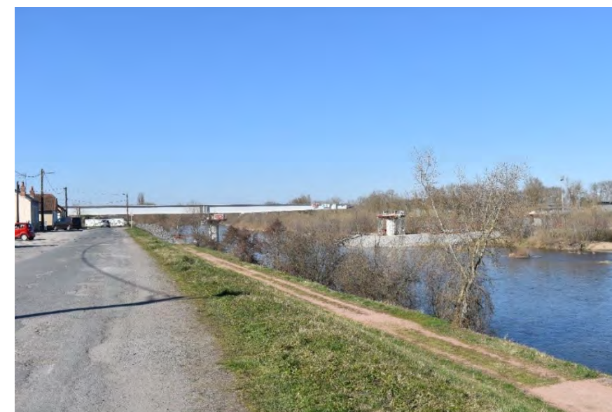
Figure 106 – Photographie illustrant le nouveau pont en construction reliant « la Madeleine » à Moulins (Source : ECO-STRATEGIE)
