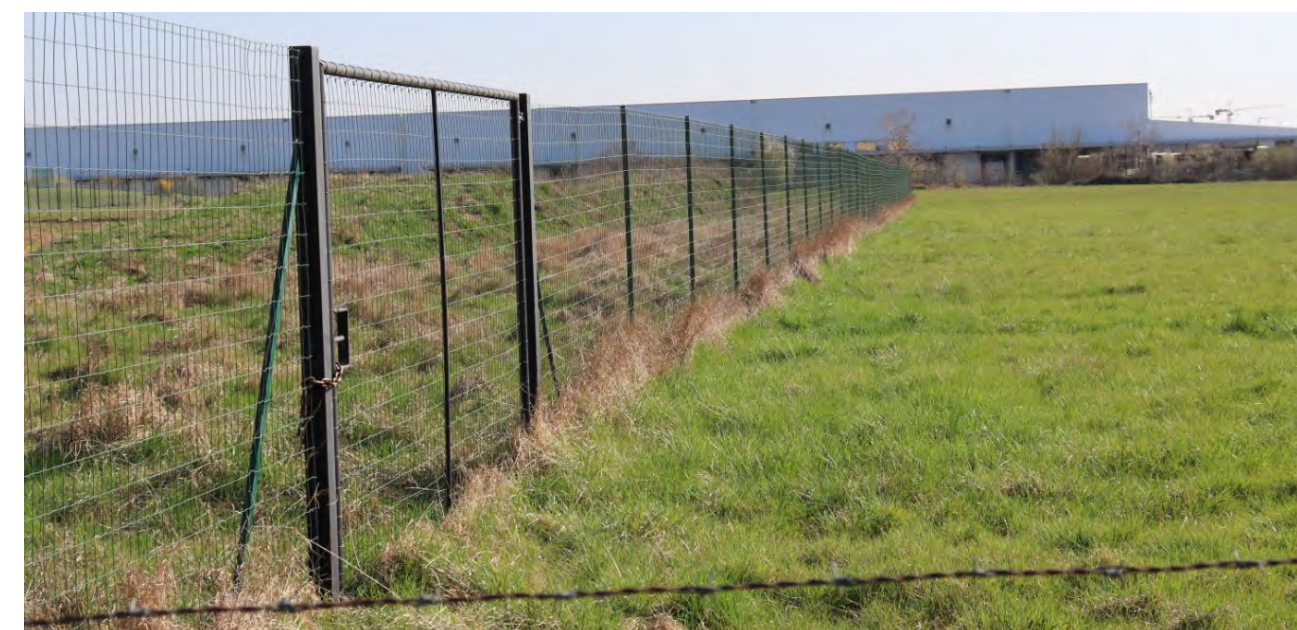
Photographie 20 - Clôture grillagée entourant la zone de stockage de matériaux (source : Eco-Stratégie, le 23.03.22)
