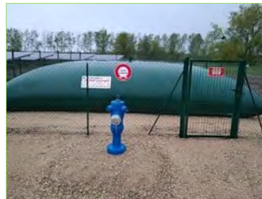
Photographie 1 – Illustration d'une citerne souple (source : PHOTOSOL)
