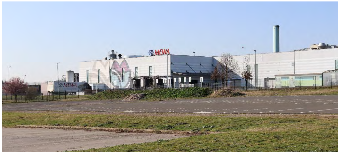
Photographie 31 - Entreprise MEWA classée ICPE (source : Eco-Stratégie, le 23.03.22)
