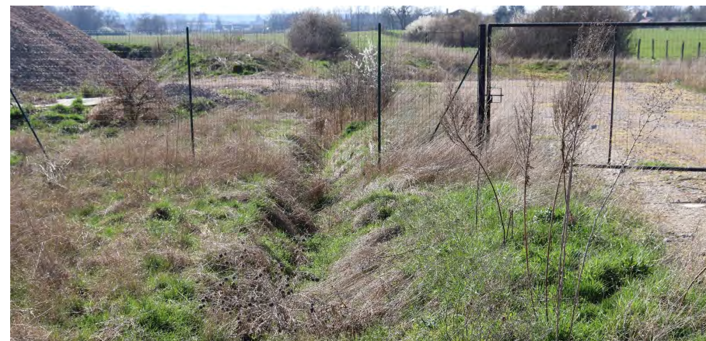
Photographie 11 - Petit fossé en eau à l'entrée de la zone de stockage de matériaux (source : Eco-Stratégie, le 23.03.22)
