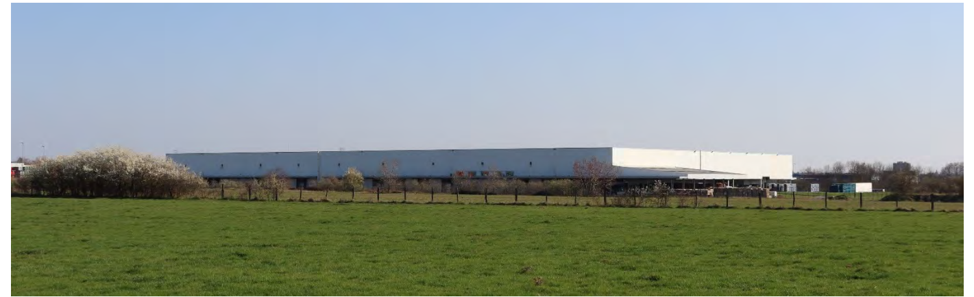
Photographie 32 - Entrepôt SCA II classé ICPE (source : Eco-Stratégie, le 23.03.22)
