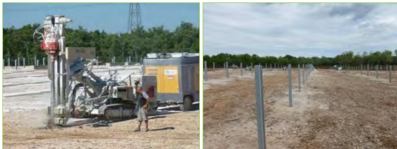
Photographie 2 – Illustration du battage des pieux (source : PHOTOSOL)
