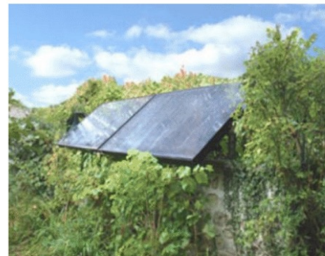
Capteurs isolés de la construction et posés au sol, ou adossés à un mur.
