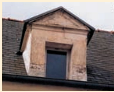
◀ Lucarne à fronton maçonnée.
