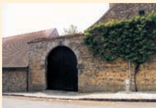
▲ Le mur est à la dimension de la porte charretière.
