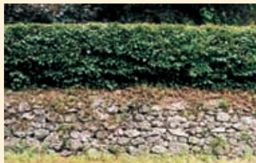
▲ Ce mur de soutènement est complété par une haie taillée dense.
