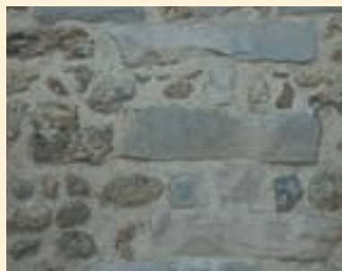
L'enduit affleure entre maillons de meulière et les pierres taillées de grès. ▼
