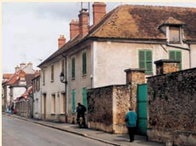
▲ La meulière du mur de clôture et la tuile ont ici une tonalité très proche.
