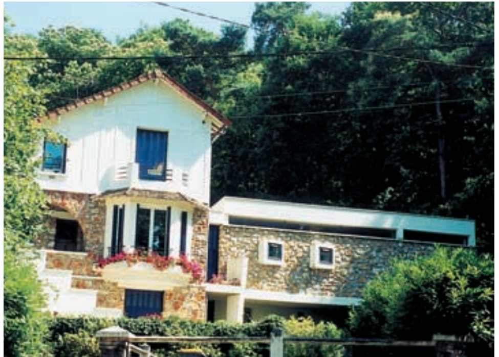
▲ Le volume de l'extension, simple, linéaire et bas, ne concurrence pas le volume ancien qu'il prolonge. La pierre de façade et la couleur de l'enduit contribuent à l'unité d'ensemble.
