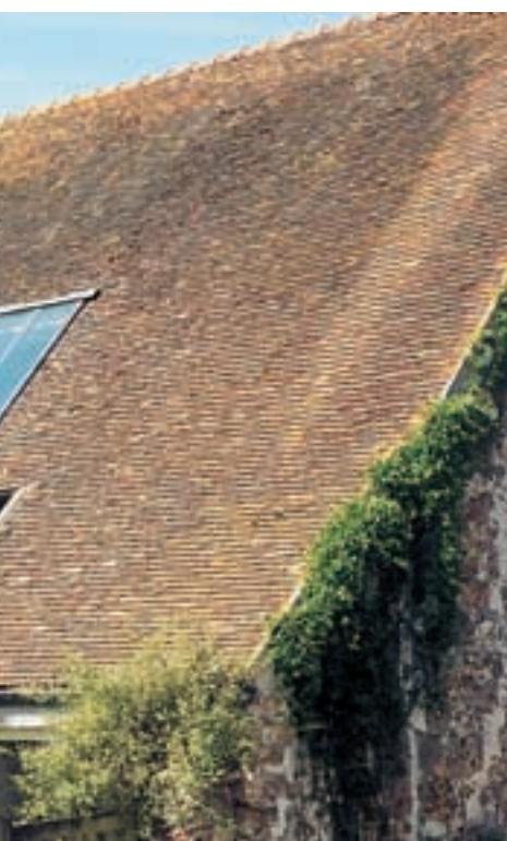
◀ La verrière aux profilés fins s'inscrit sans saillie et dans la géométrie du pan du toit, éclairant largement l'intérieur de la maison.
