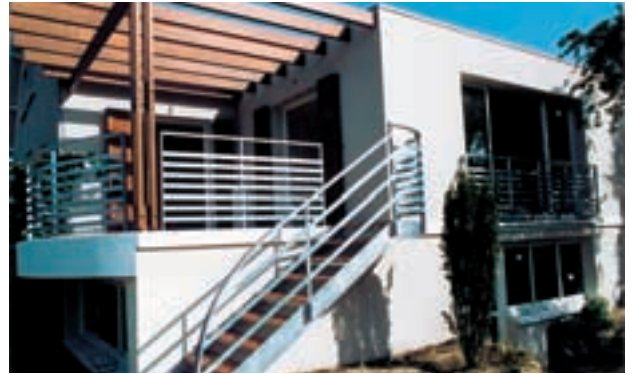
▲ À l'origine, un petit pavillon sans grande qualité architecturale et sans relation avec le terrain. L'extension, grâce à de grandes baies vitrées et un espace terrasse-pergola qui prolonge le séjour, ouvre largement la maison sur le jardin et au-delà.
