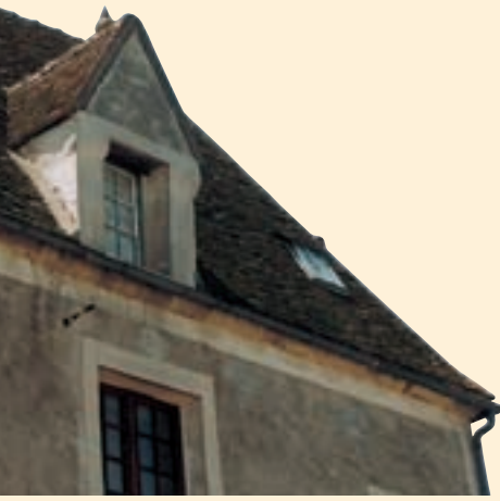
◀ Lucarne pignon maçonnée datant du XVII e siècle. Elle est assez massive, mais bien proportionnée par rapport au grand toit fortement pentu.
