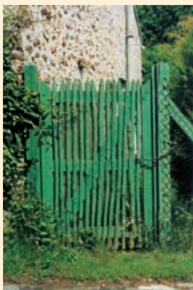
▲ Portillon en échals de châtaignier peint. Les lames de bois espacées assurent une certaine transparence. Portes et portails peuvent aussi être en planches jointives ou en panneaux de bois qui masquent les vues.
