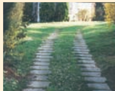
L'accès des voitures est matérialisé seulement par des dalles de béton posées sur l'herbe avec un léger décalage. ▶
