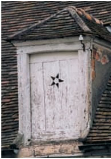
▲ Cette lucarne dite à la capucine* (toit à trois pans*) permettait l'accès aux combles et leur aération.
