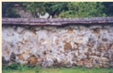
▲ Mur plein en maçonnerie de meulière.
