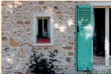
Enduit à pierre vue. ▲
