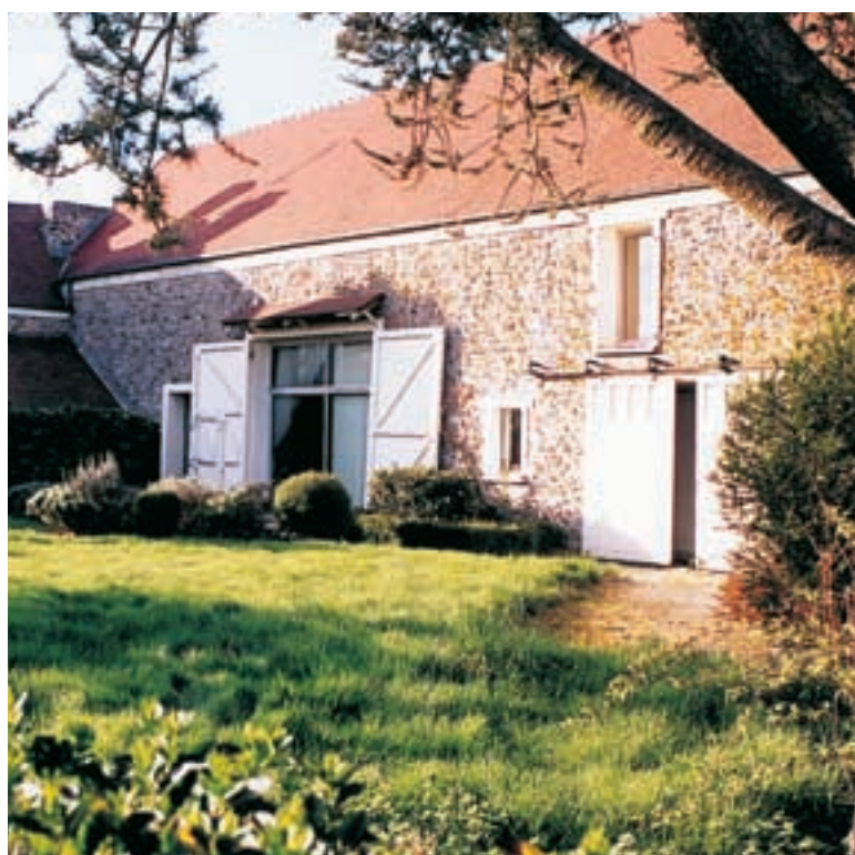
L'ouverture de l'ancienne porte de garage a été conservée mais transformée en une grande baie vitrée entre séjour et jardin, simplement redécoupée par une menuiserie en croix. ►
