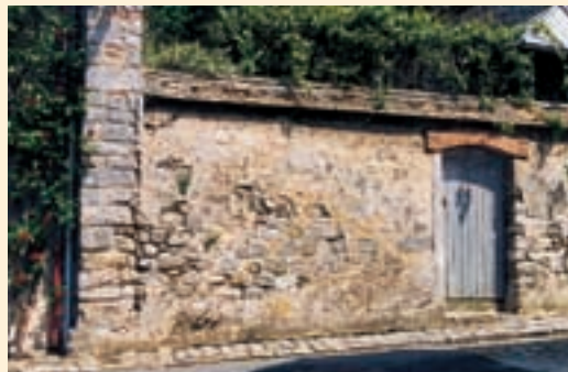
▲ Le couronnement du mur n'est pas interrompu par l'entrée.
