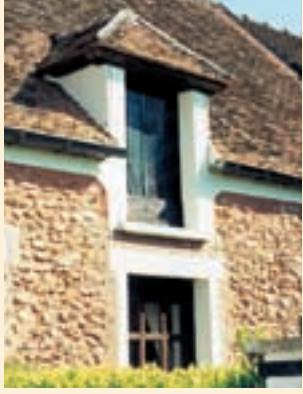
Lucarne engagée dans le mur, couverte "à la capucine". ▶
