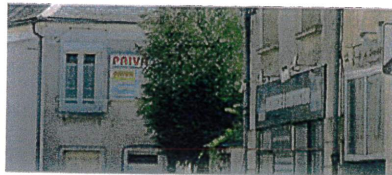
16 - panneau temporaire du chantier
