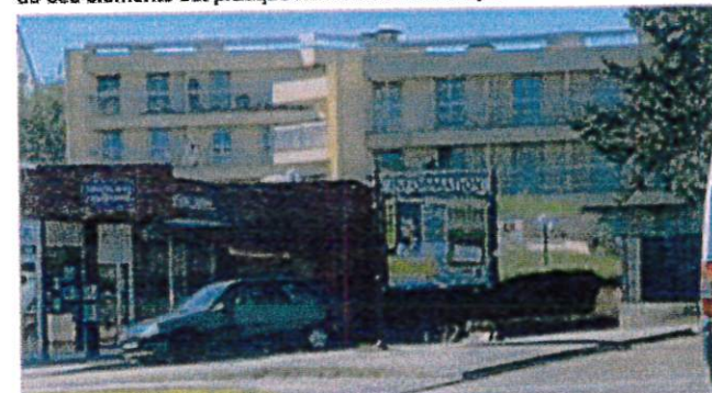
06 - affichage sur un mobilier urbain et les enseignes intégrées sur les façades
