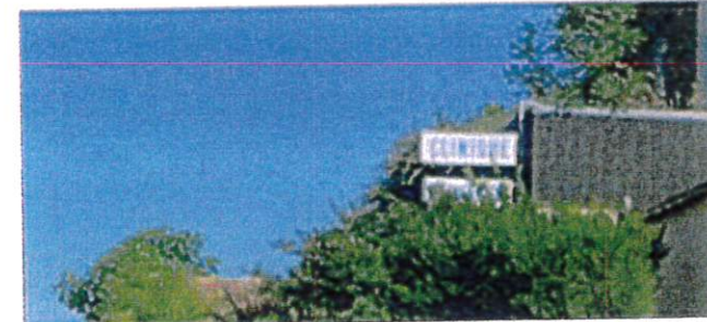
04 - enseignes toujours présentes des bâtiments désaffectés
