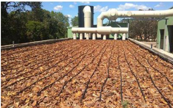
Figure 59 : Container (haut-gauche) ventilateur de désodorisation (haut droite) biofiltre ouvert (bas gauche) biofiltre couvert (bas droite)
