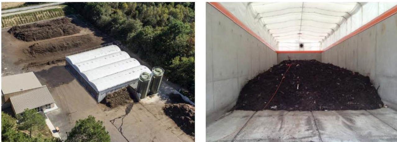
Figure 45 : Visuels des tunnels de fermentation /séchage
