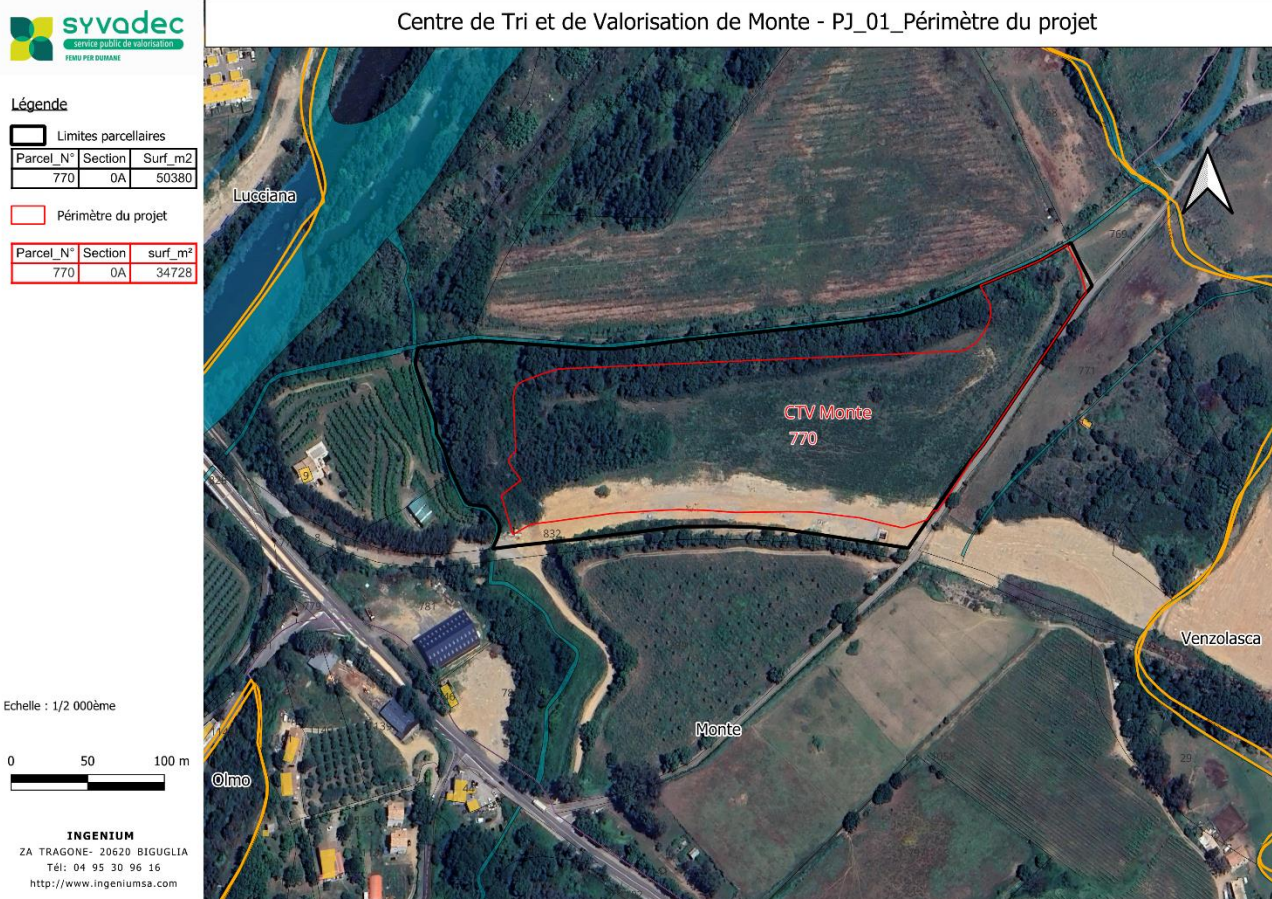
Figure 1 : Vue aérienne de la parcelle du projet
