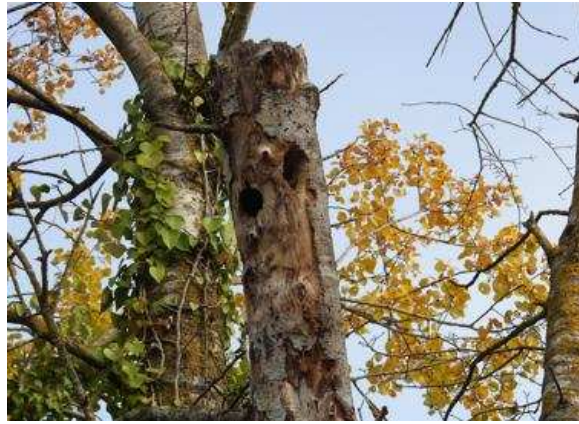
Des loges de pic sont localisées le long du chemin d'accès vers l'éolienne E03.
