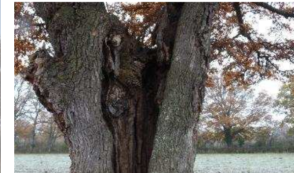
Un chêne de grande taille et fendu est localisé le long du chemin d'accès de l'éolienne E02. Plusieurs cavités y sont visibles.
