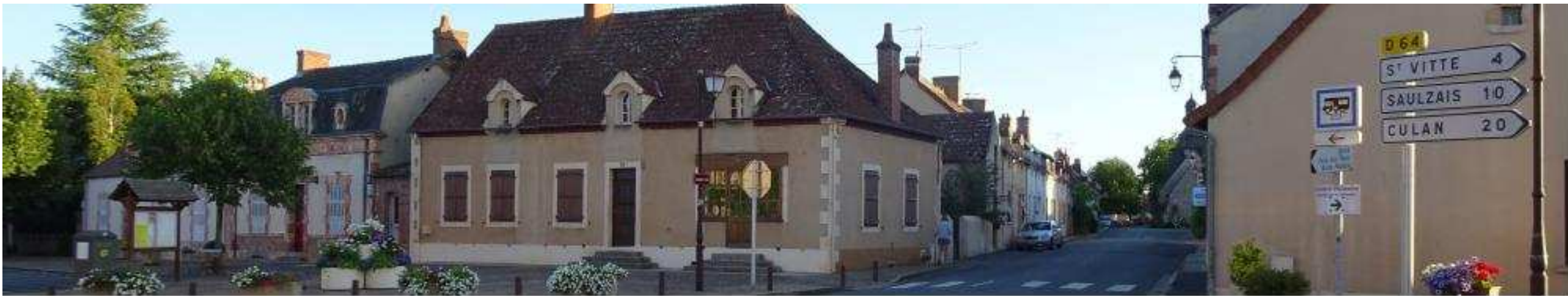
Figure 281 : Le tissu bâti est compact et ferme les perceptions visuelles vers la ZIP depuis le centre-bourg (© agence couasnon)
