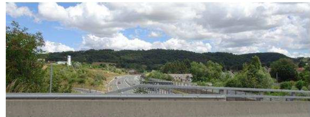
Figure 257 : La RN 145 contourne la ville de Montluçon par le nord. Le profil encaissé de la route occulte les perceptions visuelles vers la ZIP (© agence couasnon)
