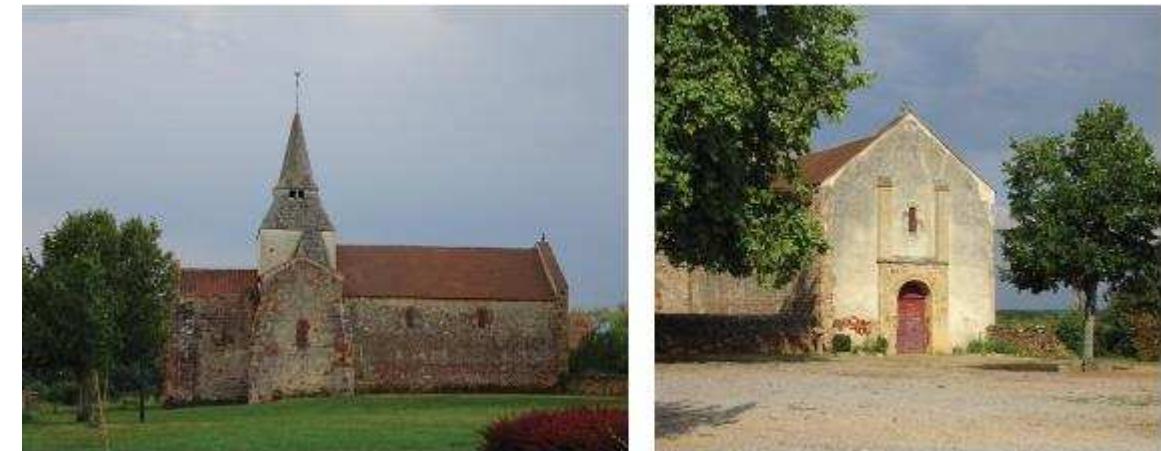
Figure 362 : Façades ouest et nord de l'église de Chazemais (© agence couasnon)
