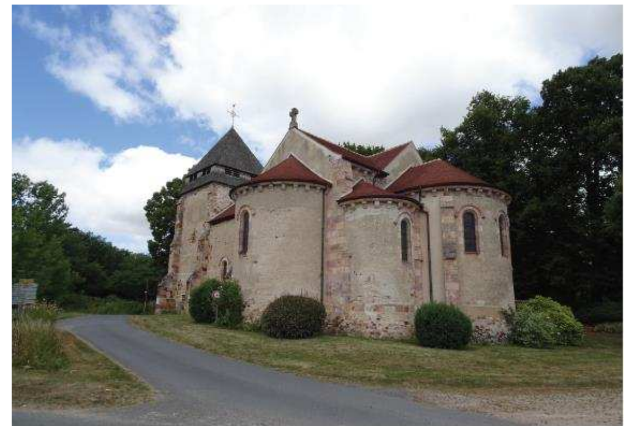
Figure 319 : Eglise de Nassigny (© agence couasnon)
