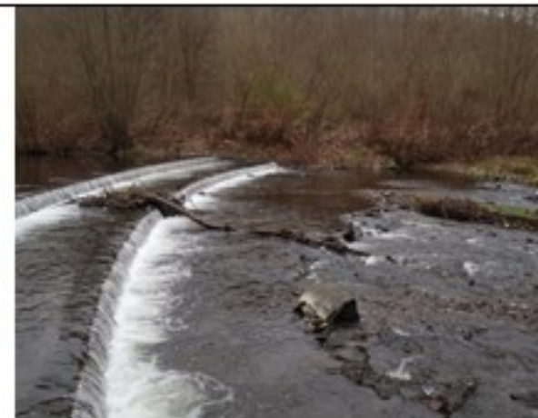
GIESSEN - Seuil 1 largeur = 25 m / 25 m cote déversement = 200,25 NGF / 199,93 NGF
