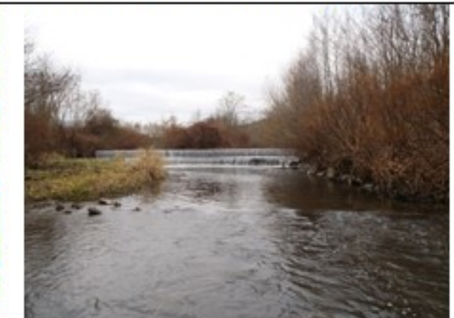
GIESSEN - Seuil 4 largeur = 23 m / 24 m cote déversement = 197,59 NGF / 196,76 NGF
