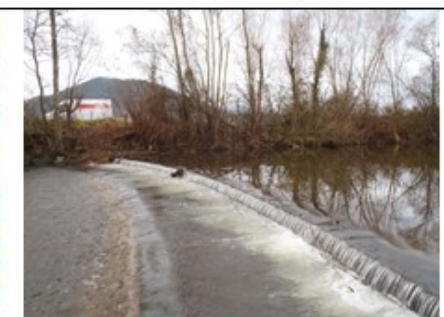
GIESSEN - Seuil 3 largeur = 17 m / 16 m / 12 m cote déversement = 198,40 NGF / 198,15 NGF / 197,84 NGF
