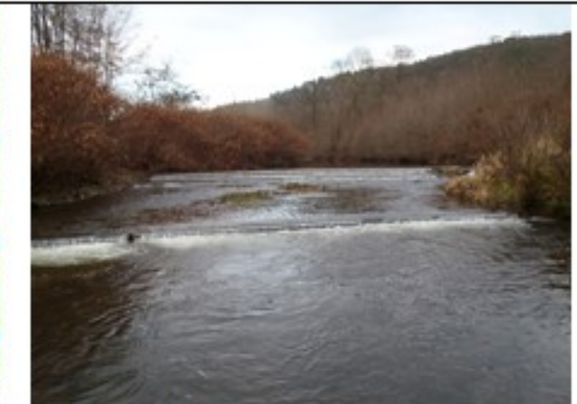
GIESSEN - Seuil 4 largeur = 23 m / 24 m cote déversement = 197,59 NGF / 196,76 NGF
