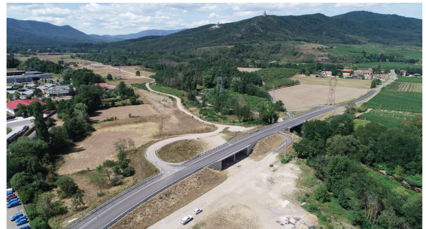
Figure 3 : Rétablissement de la route des Vins (RD35) finalisé en 2021
