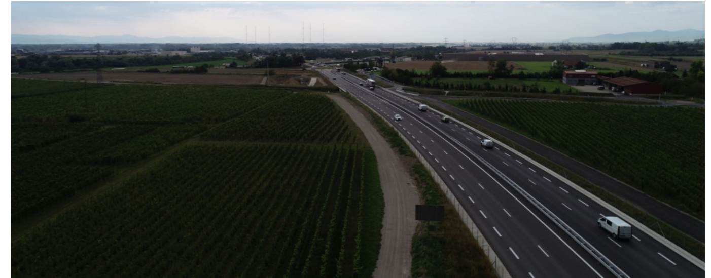
Figure 2 : Barreau Est finalisé en 2021
