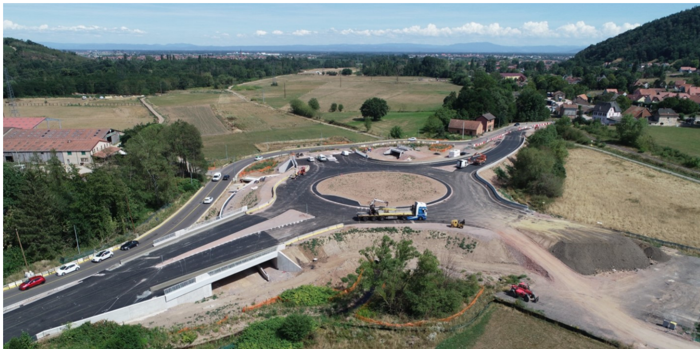
Figure 5 : Rétablissement de la route de Villé (RD424) finalisé en 2022
