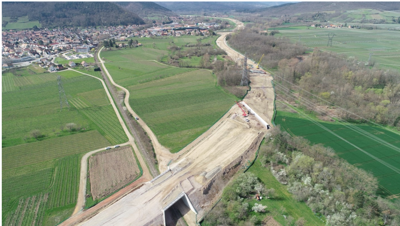
Figure 9 : Avancement des travaux de la section courante (photos du 28/03/2023, un mois et demi avant l'arrêt du chantier)
