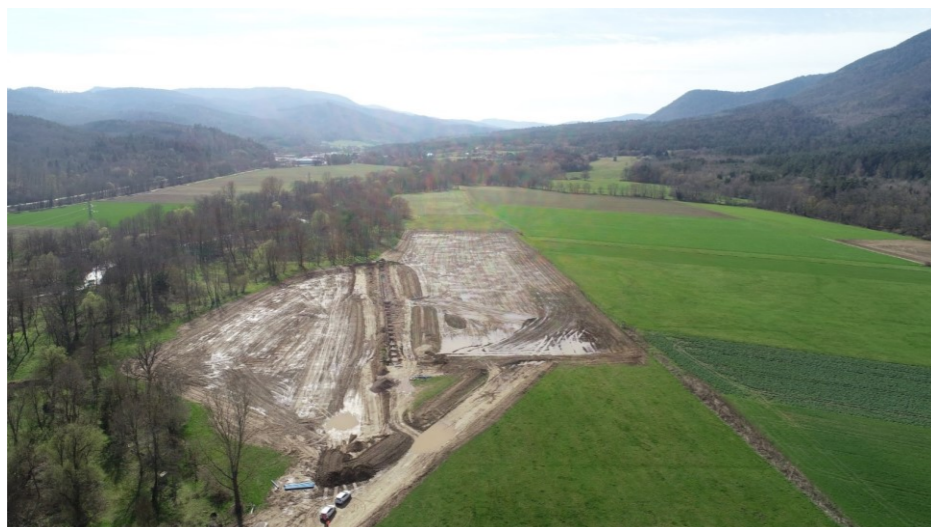
Figure 28 : Zone de compensation hydraulique Sud (avant la fin des travaux)
