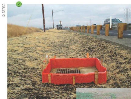
Type 1 : barrière périphérique en toile de géotextile tendue et associée à un paillage du fossé collecteur.
