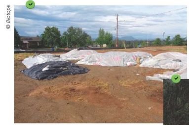
Protection de dépôts provisoires à l'aide de géomembranes.
