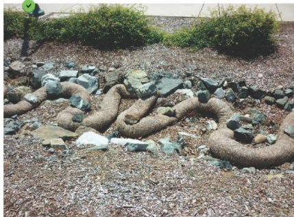
Boudin installé sur un fossé de collecte des écoulements superficiels, maintenu au sol à l'aide de blocs.
