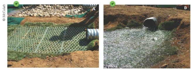
A, B - Protection d'un point de rejet à l'aide d'un tapis laminaire PEHD. Le tapis favorise l'étalement de la lame d'eau et dissipe l'énergie hydraulique. Les faibles turbulences à la surface de l'eau permettent la reprise végétale, protégeant d'autant plus efficacement les sols contre l'érosion.
