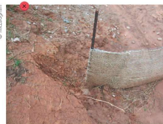
La mauvaise disposition des barrières entraîne des contours irréguliers et des processus d'érosion des talus.
