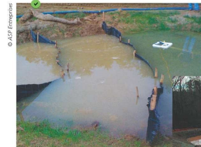
Bassin de décantation équipé de barrières perméables. L'abattement de la turbidité est visible. Attention néanmoins à ce que le niveau d'eau ne dépasse pas celui des barrières perméables.
