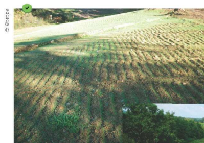
Hydroséance sur surface préalablement traitée (chenillage des sols et mise en place de cunettes). La germination est visible au creux des empreintes.
