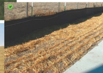
Paillage puis passage d'une charrue pour fixer la paille au sol.
