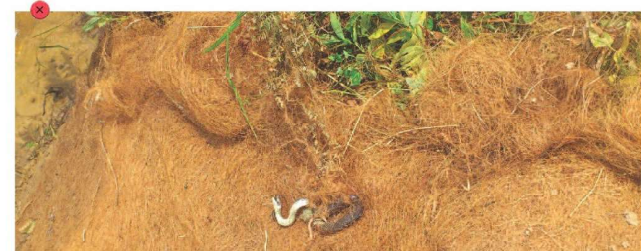
Piégeage d'une couleuvre au sein d'un géotextile à maillage synthétique.
