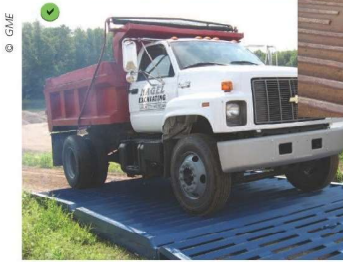
Grille métallique ondulée de protection des accès au chantier. La longueur de la grille correspond à environ 10 fois le diamètre ou 3,5 fois la circonférence des roues. La forme ondulée écarte la gomme des pneus, ce qui fait tomber la boue et les cailloux incrustés.
