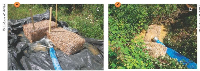
C, D - Exemples de deux dispositifs temporaires de protection des exutoires (utilisés pour quelques jours uniquement). L'option « botte de paille » n'est pas la plus économique ni la plus efficace.
