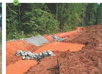
Piège à sédiments positionné en bas de pente avec fosse de récupération des écoulements.
