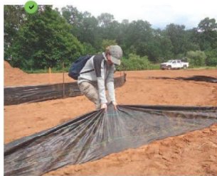
Solide ancrage au sol de la barrière de rétention.
