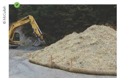
Couverture du dépôt provisoire à l'aide d'un paillage par mulch et contrôle du périmètre à l'aide d'un boudin de rétention.
