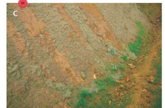
A - Bonne couverture d'hydroseeding de 100 % avec mulch, réalisée sur une surface fortement pentue. La projection a été effectuée depuis le haut et sur le côté afin d'assurer une couverture uniforme. B - La même surface, trois mois plus tard. C - Glissement du mulch sur un talus lissé. La préparation de la surface décapée avec des empreintes horizontales (ou autres microreliefs) est nécessaire quand la pente devient importante. D - Couverture insuffisante d'hydromulch : le sol est visible à travers le mulch.
