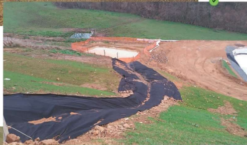
Descente d'eau provisoire sur remblai de grande hauteur, associé à un piège à sédiments. En cas de risque élevé de réchauffement de l'eau, prévoir si possible une ré-infiltration de ces écoulements en aval.
