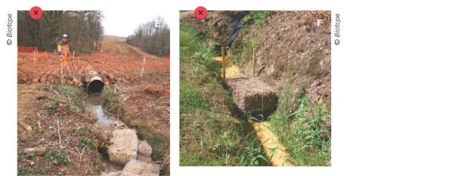
E, F - Bottes de paille insérées dans un gabion et mises en place en aval du point de rejet. La mauvaise installation de ces gabions rend les dispositifs inefficaces voire contre-productifs.
