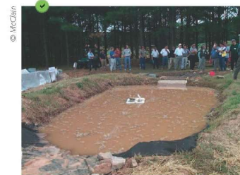
Piège à sédiments avec berges végétalisées.
