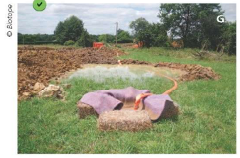
E, F - Bottes de paille insérées dans un gabion et mises en place en aval du point de rejet. La mauvaise installation de ces gabions rend les dispositifs inefficaces voire contre-productifs.
