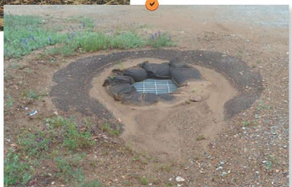
Type 1 : barrière périphérique en sac de graviers. Fonctionnelle mais à désen-graver.
