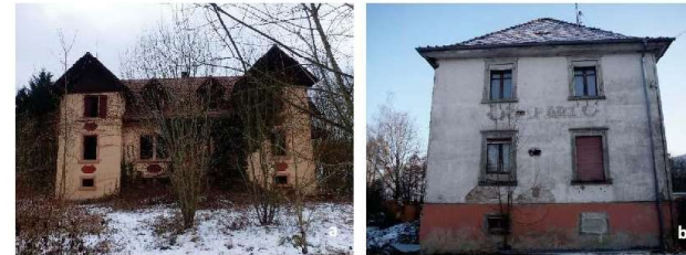
Figure 1 : Bâtiments expertisés en Janvier 2017 (a : Villa ; b : Restaurant)
