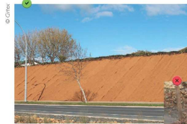
Reprise de talus routier à l'aide d'un géotextile coco.
