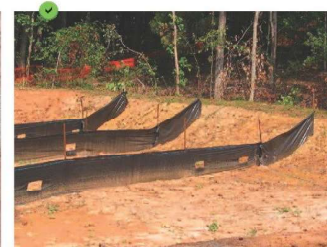
Fixation correcte des barrières géotextiles.
