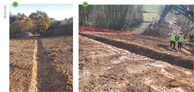
Cunettes successives, sur une piste provisoire de circulation des engins, collectant les écoulements superficiels et les dirigeant vers une zone végétalisée située de part et d'autre de l'emprise du chantier. Les points de rejet sont munis de dispositifs anti-érosion.
