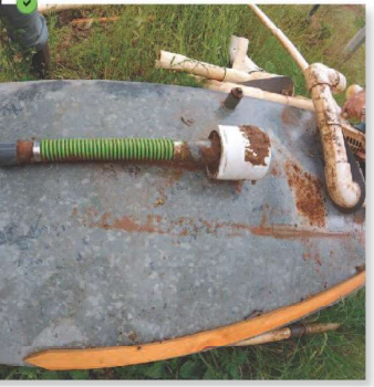
Installation d'un skimmer au sein d'un bassin de décantation provisoire.
