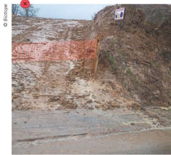
Accès au chantier non aménagé.
