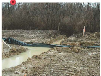
Ne pas installer de barrières de rétention en travers des cours d'eau.
