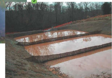
Bassin de décantation aux berges végétalisées et équipé de barrières perméables en toile coco.
