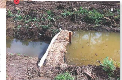
Paille décompactée dans un cadre métallique : A - avec surverse sur le côté B - associée à une géomembrane Ces dispositifs créent un effet de seuil qui à terme, peut pousser les eaux à les contourner en érodant les talus sur le côté. Ils perdent alors toute leur efficacité.
