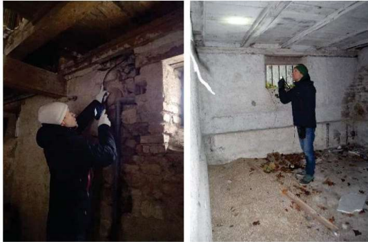
Figure 3 : Inspection à l'aide d'une lampe et/ou d'une caméra endoscopique
