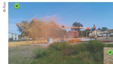
Exemple d'un paillage en cours.
