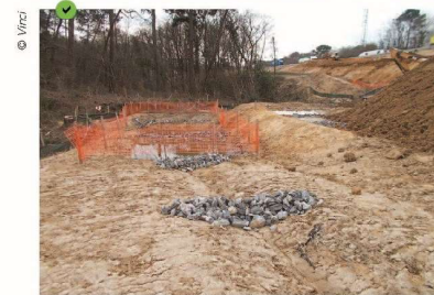
Fossé équipé de seuils en série en amont immédiat d'un piège à sédiments.
