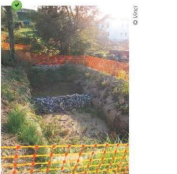
Barrière perméable rebâchée à l'aide d'un tas de granulats grossiers.
