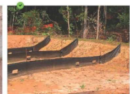
Fixation correcte des barrières géotextiles
