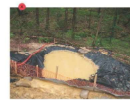
Dispositif de surverse à gabion de pierre.
