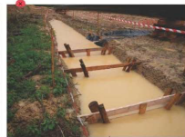
Fossé de décantation inefficace : surcoût très élevé, les particules de plus de 100 µm ne sont pas.
