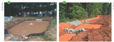
Piège à sédiments avec berges végétalisées.
