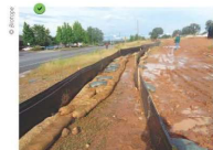
Double barrière de rétention installée à la périphérie de l'emprise du chantier et configurée à des boudins en béton de couleur marquant au sol par des sacs de gravier.
