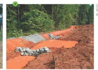
Piège à sédiments occasionnel en bas de pente avec fosse de récupération des écoulements.
