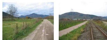
Figure 60 : Chemin rural le long de la voie ferrée
