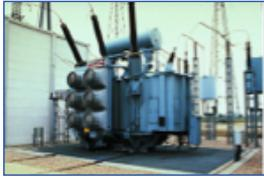
Ces appareils modifient la tension électrique (par exemple de 400 000 à 225 000 volts).
