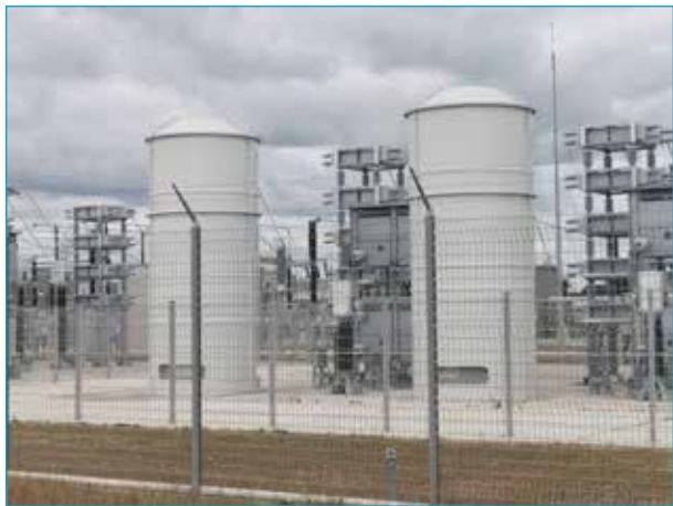
Exemple de selfs de compensation
