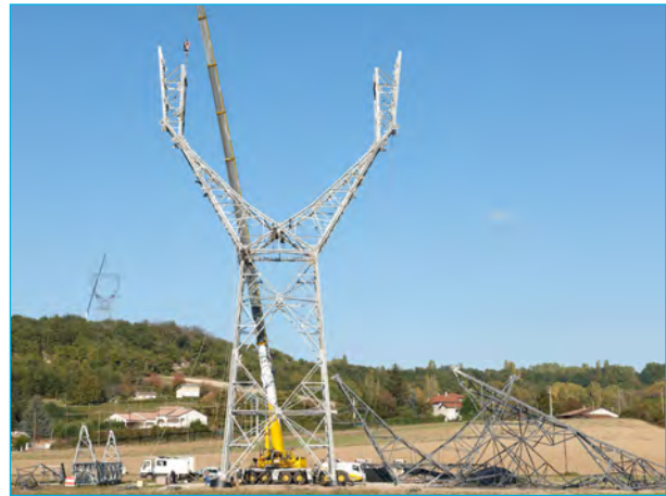
Montage d'un pylône
