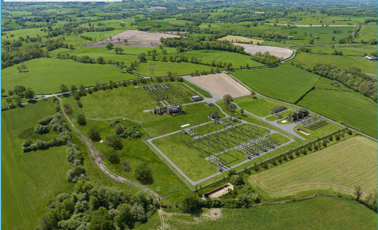
Vue aérienne: situation future
