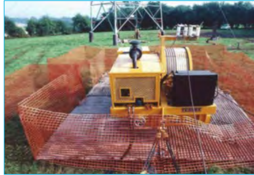
Plateforme de déroulage
