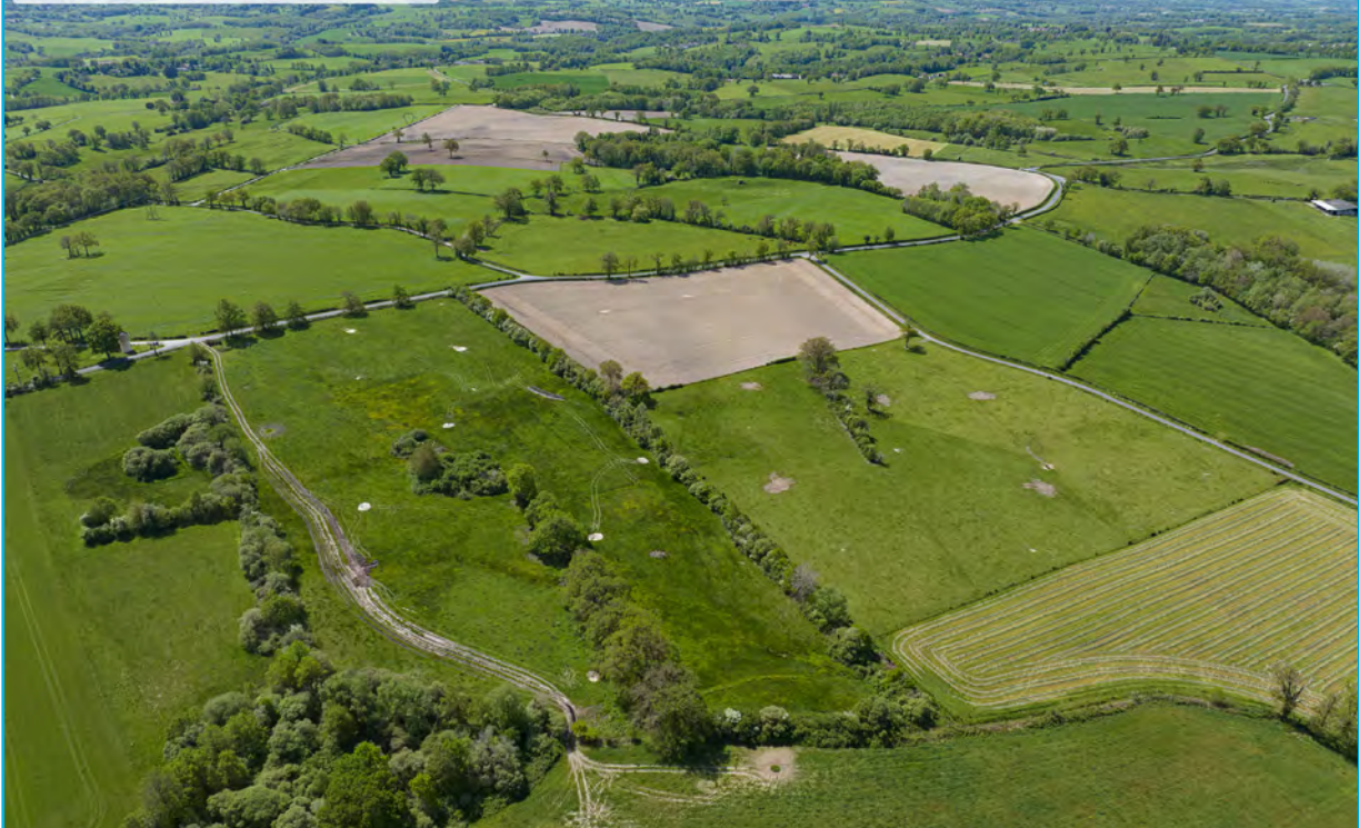
Vue aérienne: situation actuelle
