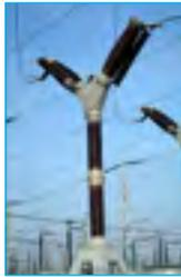
Ces appareils protègent le réseau contre d'éventuelles surcharges dues à des courants de défaut (foudre, arc électrique avec branche d'arbre...) en mettant des portions de circuit sous ou hors tension.
