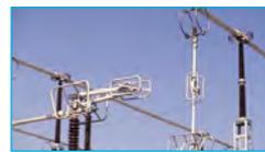
Ces appareils assurent la coupure visible d'un circuit électrique et aiguillent le courant dans le poste.
