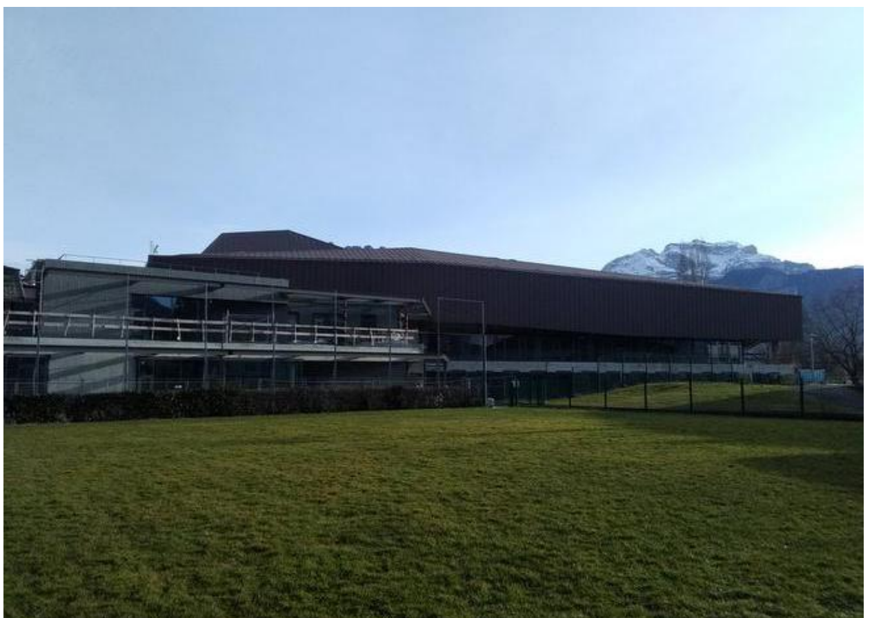
A Saint-Jorioz, le nouveau gymnase devrait ouvrir d'ici mai 2025.
