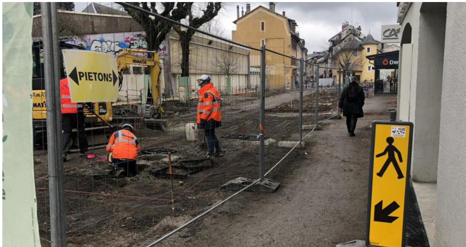
Les travaux vont bon train sur le Faubourg Montmélian.
