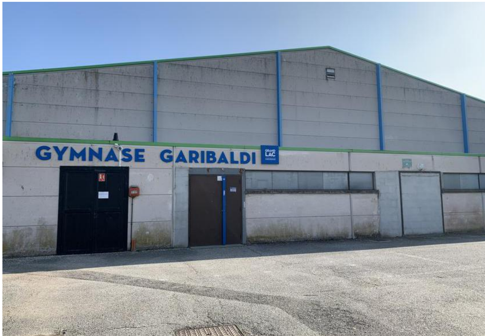
Les performances énergétiques du bâtiment vont être améliorées grâce notamment à la pose de panneaux photovoltaïques et à un système de chauffage à bois.
