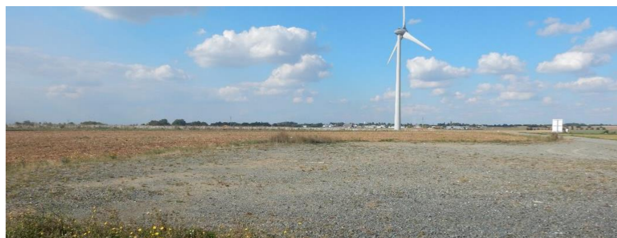
Photo 3 : un exemple d'aire de grutage depuis le pied d'une éolienne
