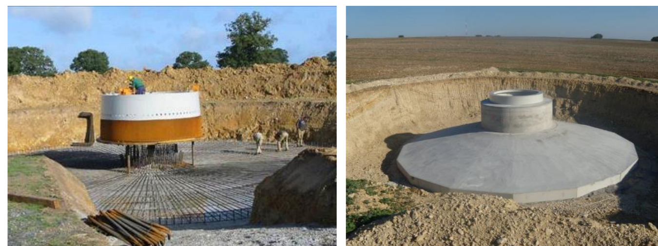
Photo 1 : Le coulage d'une fondation d'éolienne
