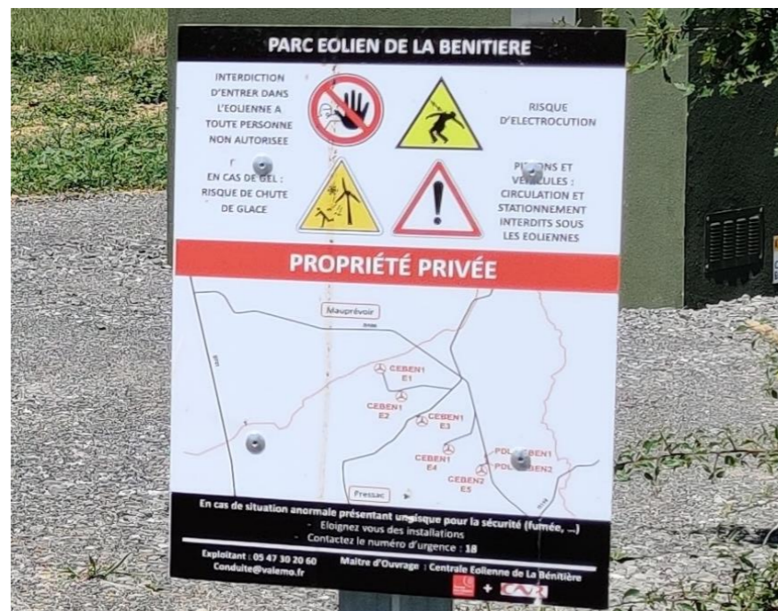
Figure 8 : Exemple de panneau de prévention des risques sur un parc éolien
