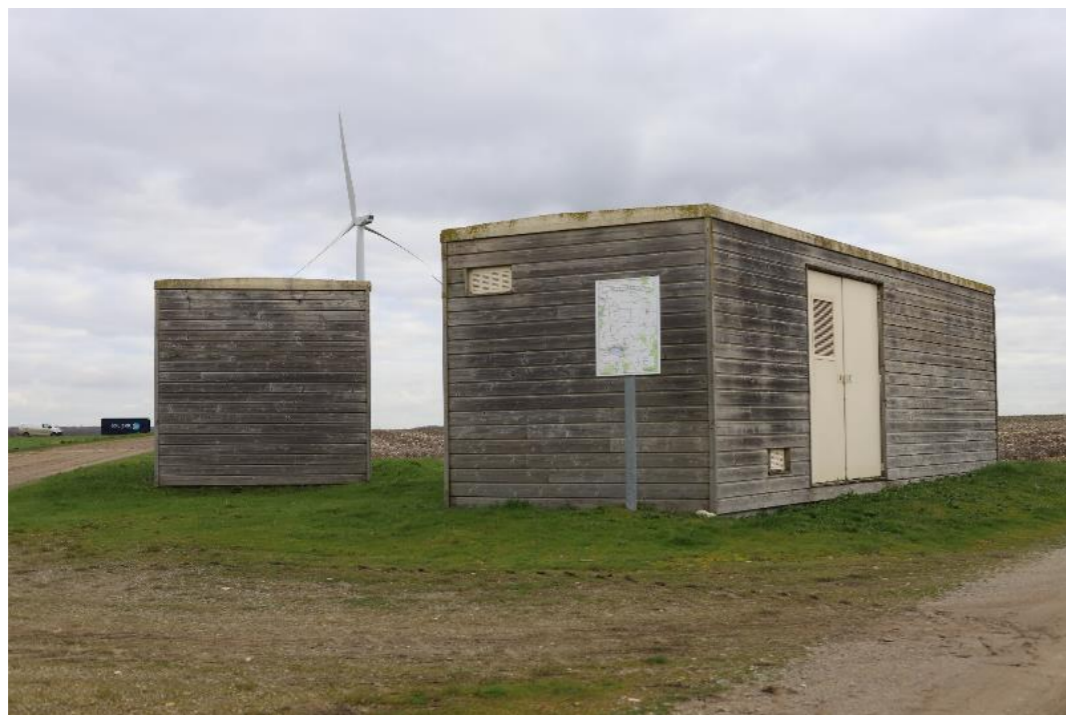
Photo 201 : Exemple d'un poste de livraison bardé de bois (Source : AEPE-Gingko, 05/02/2020)
