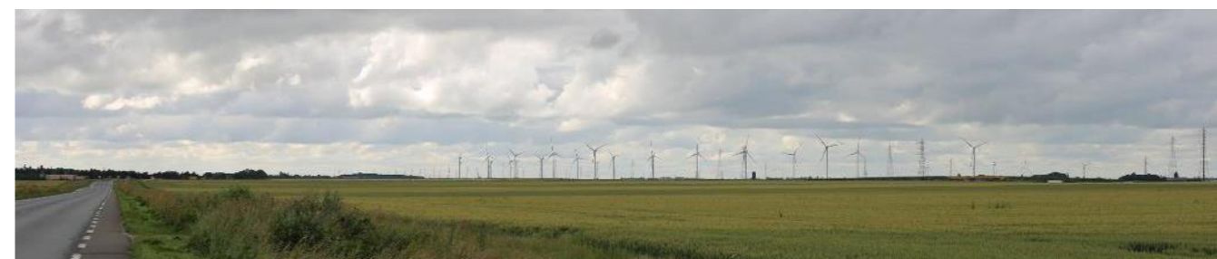
Photo 46 : Pylônes électriques et éoliennes constituent des éléments verticaux qui se détachent de l'horizontalité du plateau
