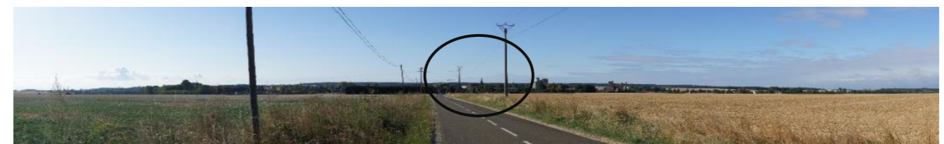
Photo 170 : Depuis la RD 941, une covisibilité est relevée entre la silhouette de l'église et la zone de projet située en arrière-plan à 4 km
