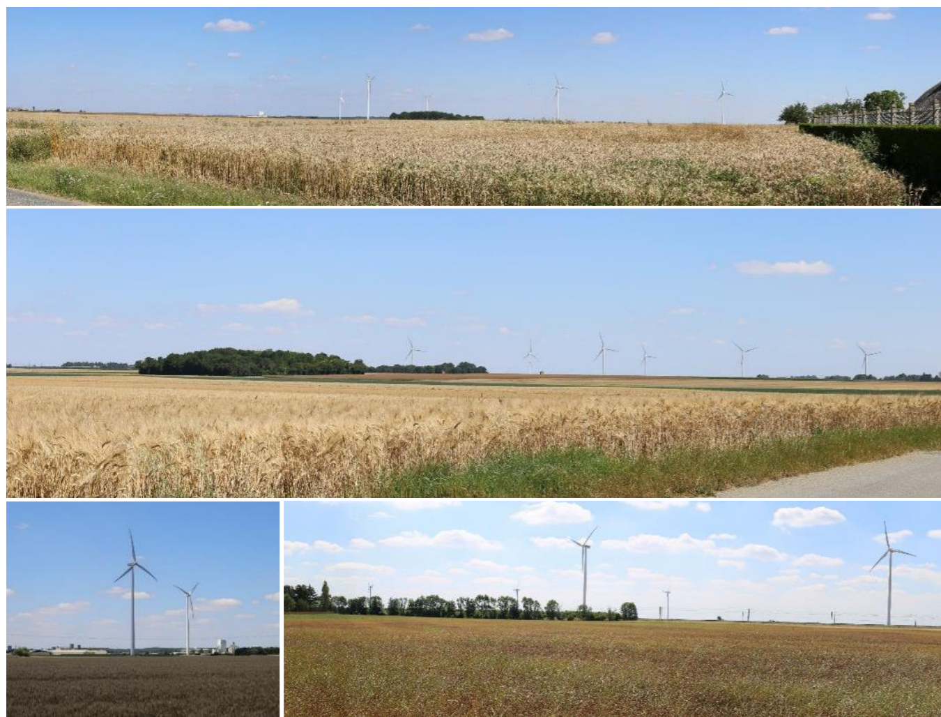
Photo 128 : Le parc de Bonneval est constitué de 4 éoliennes alignées sur un axe et de deux éoliennes distantes d'environ 1 km au nord
