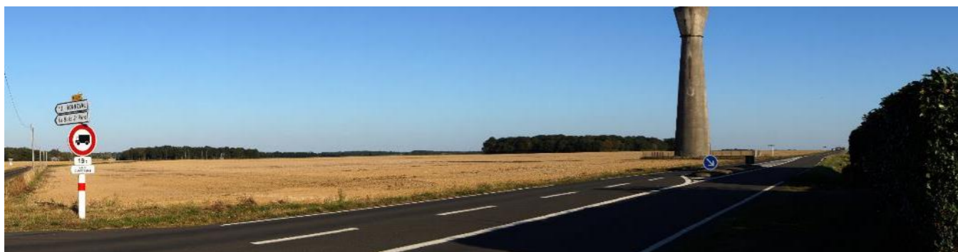
Photo 110 : À proximité de Logron, perception franche sur la zone de projet depuis la RD 955
