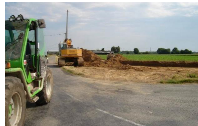
Photo 200 : Les travaux de rectification d'un virage
