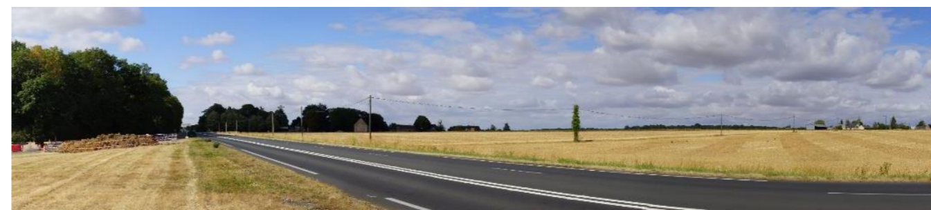
Photo 107 : À la sortie de Bonneval, la zone de projet est perceptible depuis la RN 10
