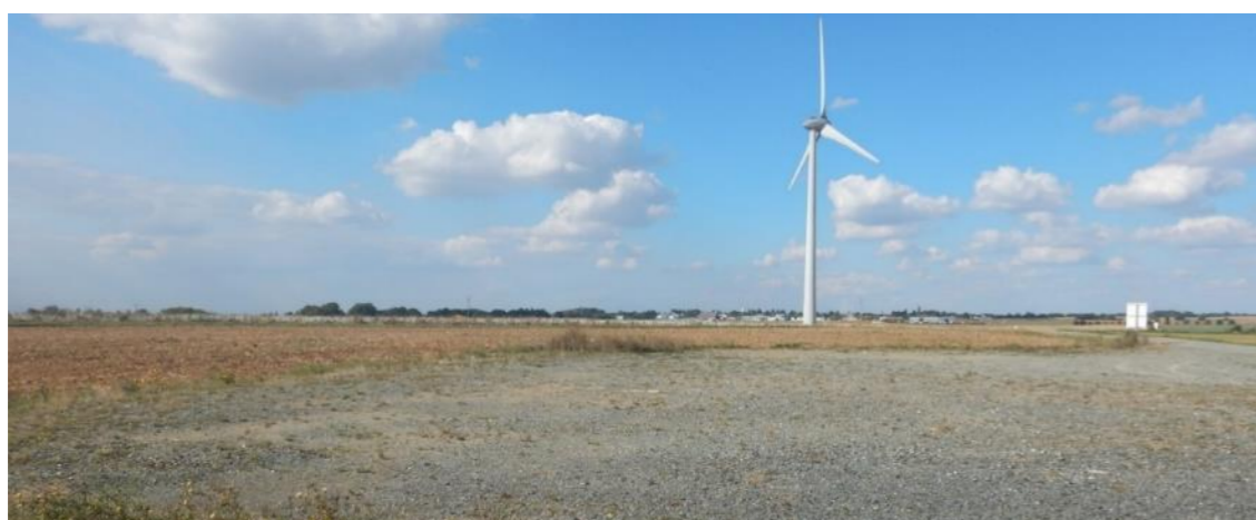
Photo 193 : Exemple d'aire de grutage depuis le pied d'une éolienne
