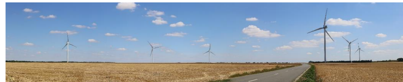
Photo 129 : Le parc éolien du Moulin de Pierre avec ses 6 éoliennes construites de part et d'autre de la RD 17
