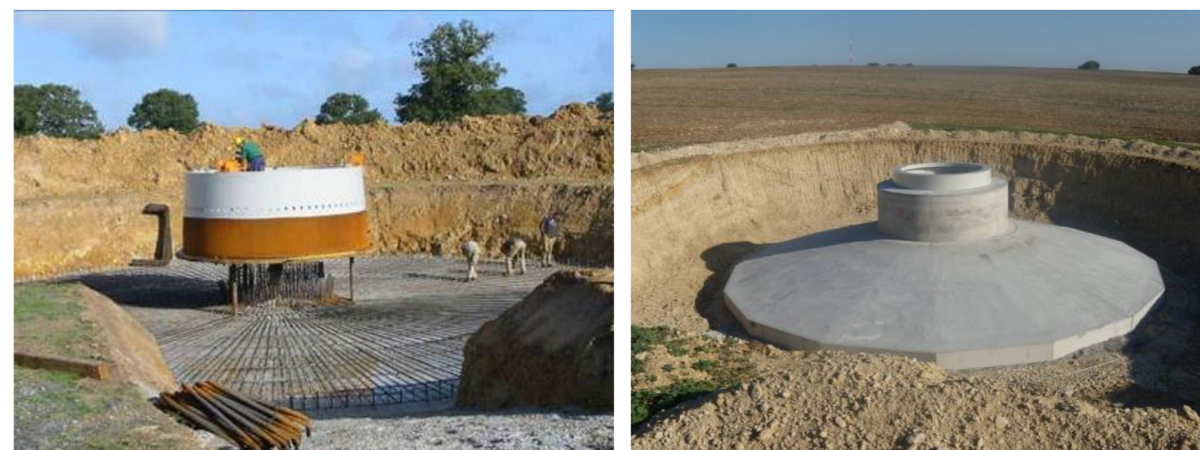
Photo 191 : Le coulage d'une fondation d'éolienne
