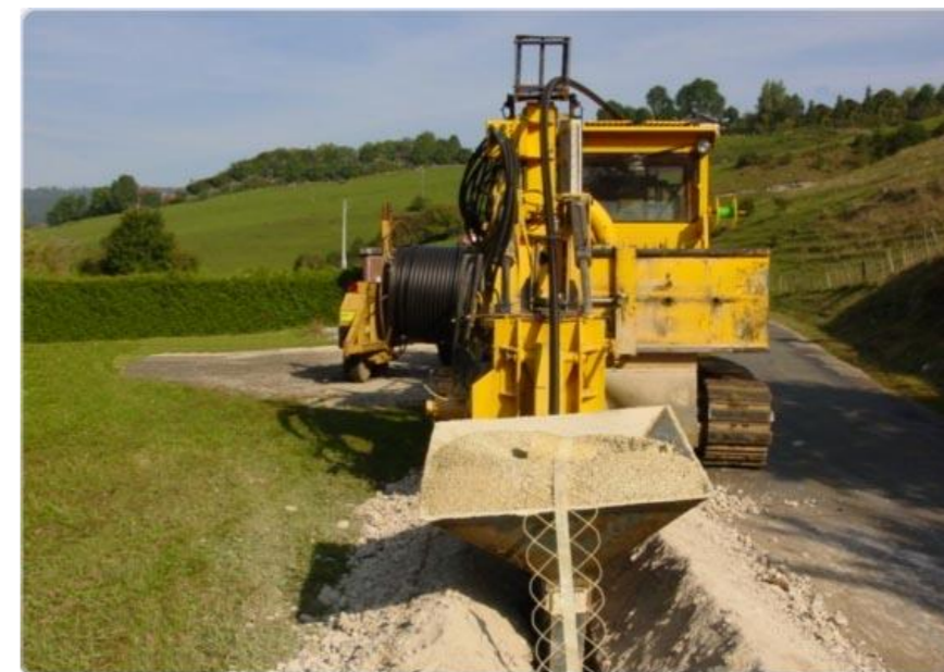
Photo 196 : La pose d'un câble souterrain depuis le poste de livraison jusqu'au réseau électrique public
