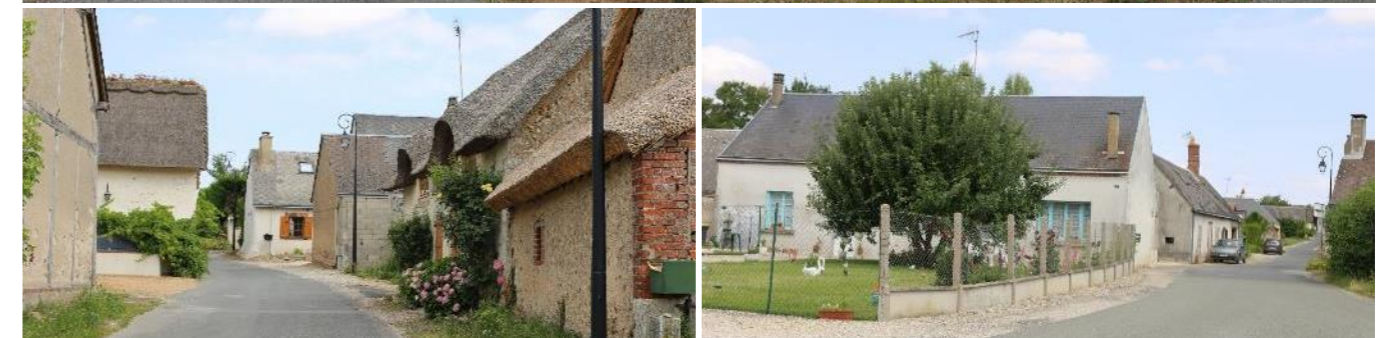
Photo 103 : Le hameau s'est construit dans le creux de la vallée de la Conie
