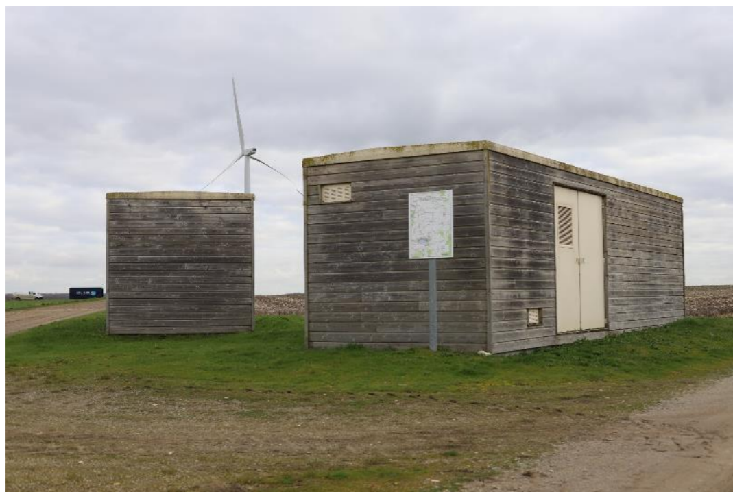
Photo 147 : Exemple d'un poste de livraison bardé de bois (Source : AEPE-Gingko, 05/02/2020)
