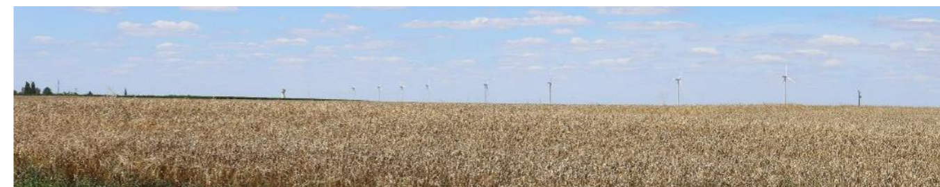
Photo 86 : Perception sur l'alignement des 8 éoliennes du parc de Neuvy et Villars
