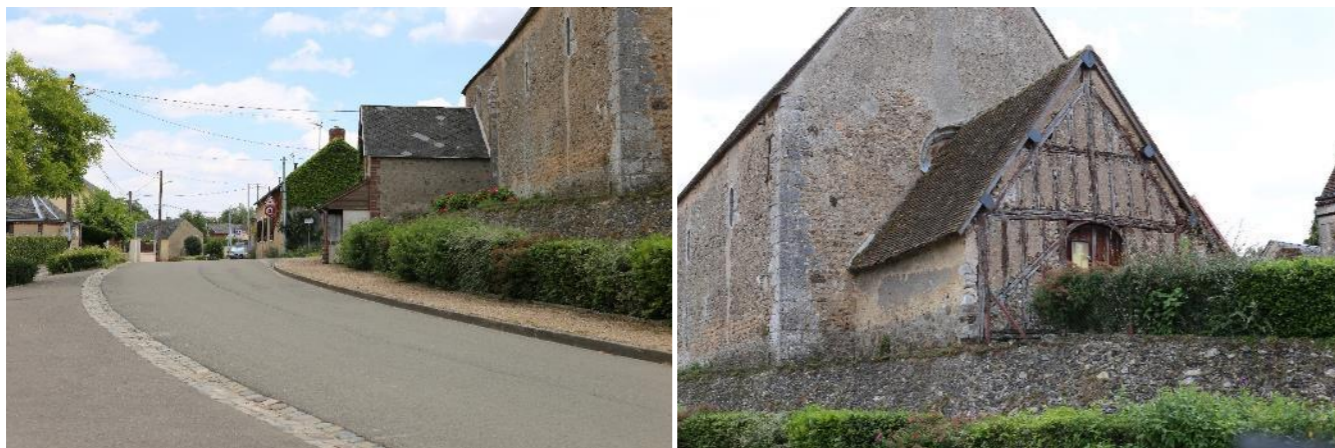
Photo 128 : Depuis le parvis de l'église aucune percée visuelle en direction de la zone de projet n'est relevée
