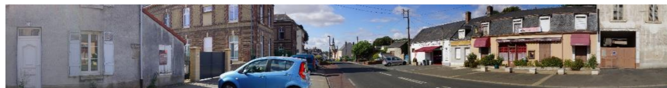
Photo 43 : Depuis le cœur du bourg en point haut, une covisibilité potentielle est soulevée avec la clocher car la zone de projet est située dans l'axe de la rue
