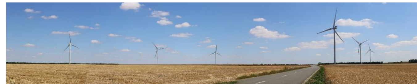
Photo 85 : Le parc éolien du Moulin de Pierre avec ses 6 éoliennes construites de part et d'autre de la RD 17
