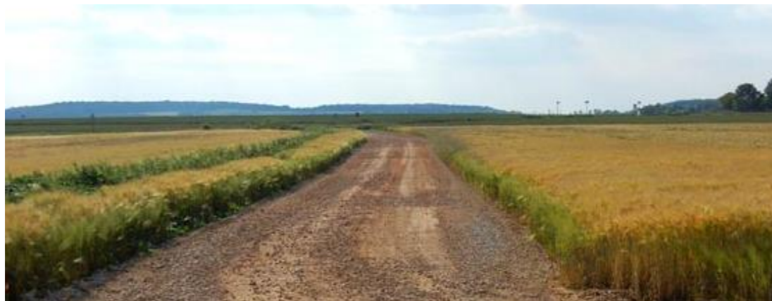
Figure 14 : Exemple de voie d'accès à un parc éolien
