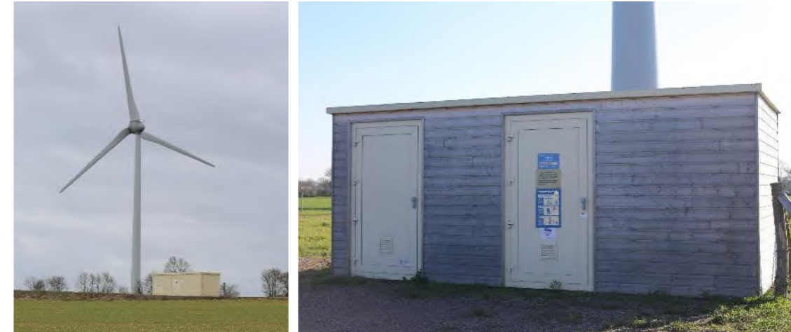
Figure 15 : Exemples de poste de livraison électrique
