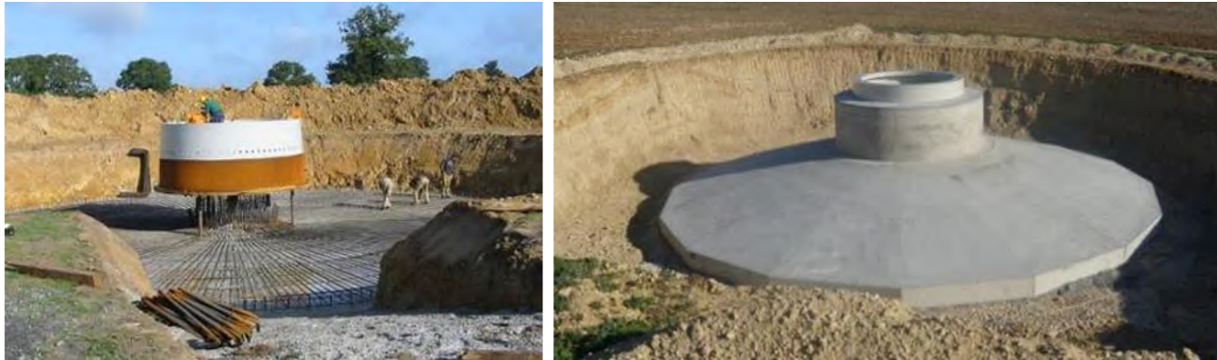
Figure 13 : Le ferrailage et le coulage d'une fondation d'éolienne
