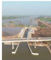
Au Vietnam, après plusieurs années d'études, CNR supervise en association avec Egis et son partenaire vietnamite VICO le nouveau de construction d'un canal de jonction entre deux bras du fleuve Rouge, équipé d'une écluse à grand gabarit et d'un vaste roulier.
