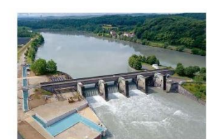
Ouvrage de franchissement piscicole de Villebois (73)
