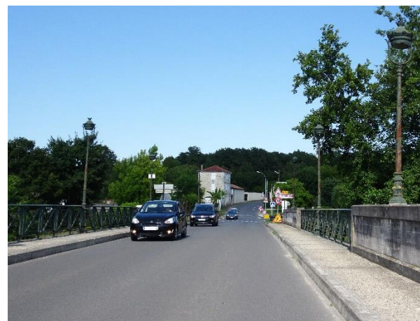
Entrée de ville « de qualité » grâce à la traversée de la Charente mise en valeur grâce à la présence de ripisylve et de garde-corps de qualité, entrée d'Angoulême par la RD72
