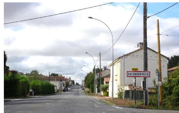
Entrée de ville « dégradée » à cause d'une urbanisation linéaire le long de la route et d'une très large voirie à l'ambiance très routière, entrée Nord de la Chignolle à Champniers
