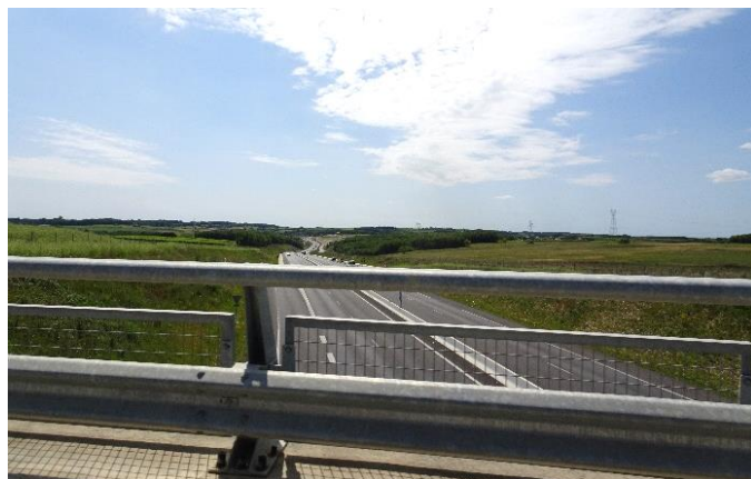
RN141 et ses 4 voies traversant les paysages agricoles ouverts
