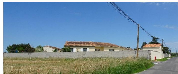
Long mur non enduit dégradant l'aspect de la frange, Vindelle
