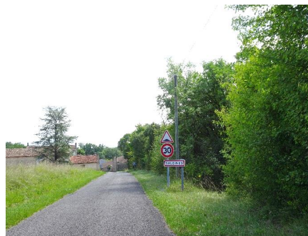
Entrée de ville « de qualité » grâce à la présence d'une haute haie et à la perception de patrimoine bâti, entrée Nord de Salzines à Asnières-sur-Nouère
