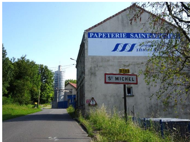
Entrée de ville « dégradée » à cause d'une très grosse enseigne sur un pignon, entrée Nord de Saint-Michel
