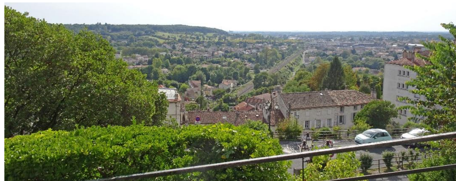
Depuis le rempart Desaix, vue sur les quartiers résidentiels d'Angoulême et la colline Saint-Martin à l'arrière-plan
