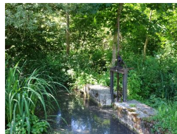
Petite écluse sur l'Echelle à Sers
