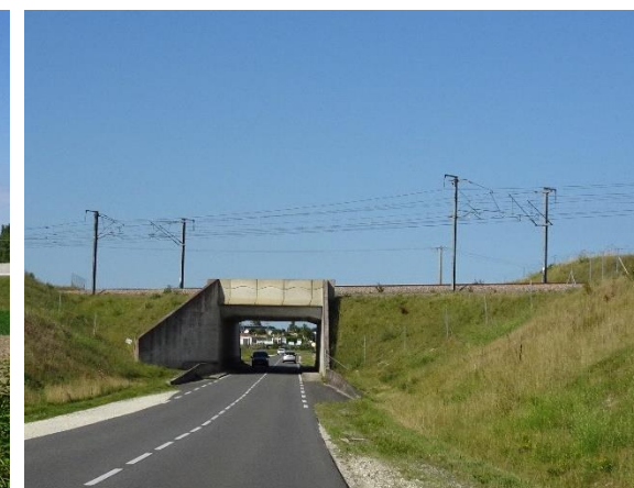
Passage sous la LGV entre la Chaume et Bel Air à Roulet-Saint-Estèphe
