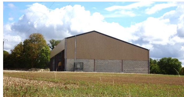
Bâtiment agricole non intégré par une lisière végétale et au soubassement non enduit, Tartassonne à Brié
