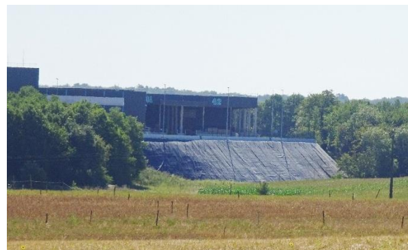
Très haut talus surplombé d'un bâtiment d'activités sans lisière végétale ne permettant ainsi pas son intégration, site du PESA à Roulet-Saint-Estèphe
