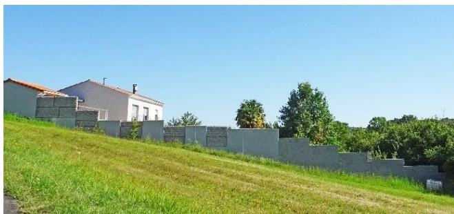
Mur de clôture en terrasse fait de parpaings non enduits, d'autres enduits et de gabions, le tout ne s'intégrant pas au paysage en bordure de ruisseau, Sud de Chez Verguin à Claix
