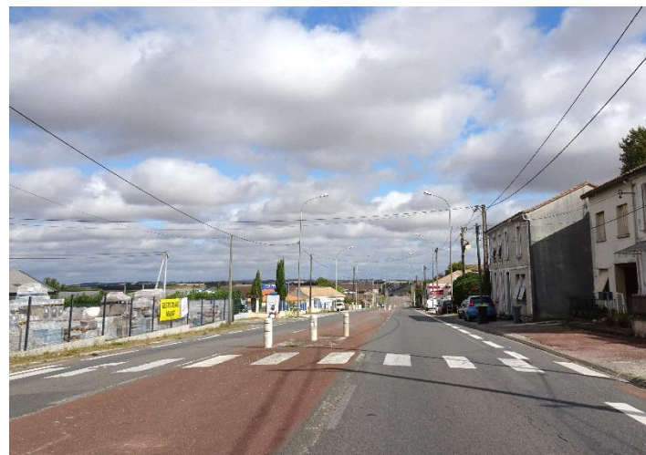
Ancienne emprise de la RN10 : aujourd'hui, voirie surdimensionnée par rapport aux usages, ambiance très routière
