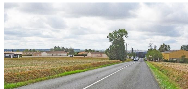
Entrée de ville « dégradée » à cause des murs de clôture opaques, de la couleur jaune d'un bâtiment et de l'absence de transition végétale, Entrée Nord de chez Nauve à Champniers
