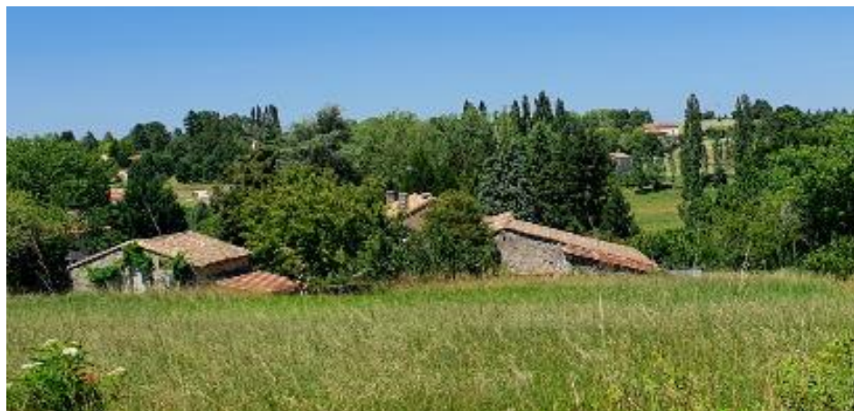
Anciens bâtiments agricoles / Bouëx
