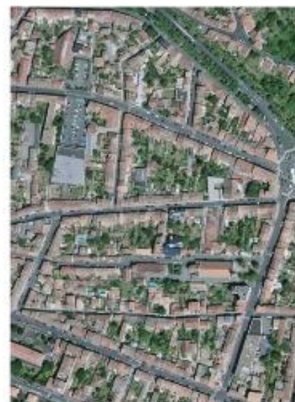
RUE SAINT-ROCH / RUE MONLOGIS / RUE CHÂTEAUBRUN ANGOULÊME
