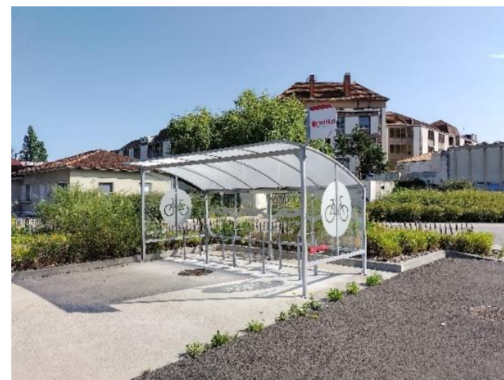
Abris vélo du parking Girac
