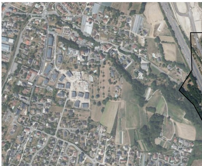
Source : image satellite IGN 2019- le deuxième secteur était alors en construction (aujourd'hui terminé voir photo ci-contre et ci-dessous)
