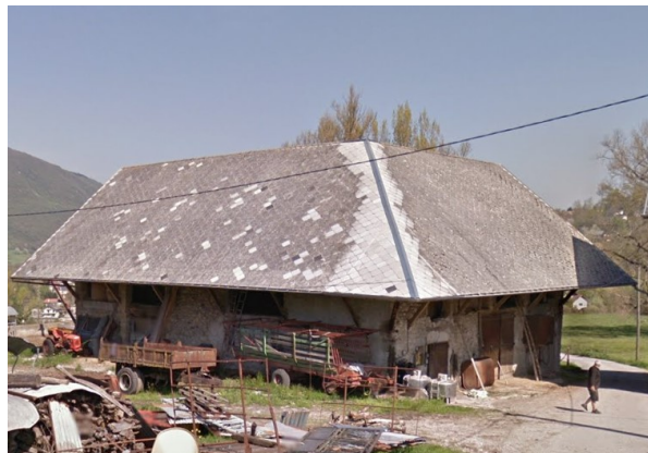
Photographie de la construction concernée par l'identification d'un potentiel changement de destination sur la parcelle D0311
