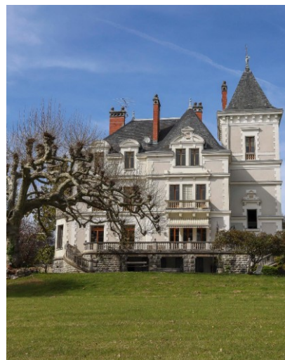
Photographie de la construction identifiée en tant que Changement de destination (source VMF)
