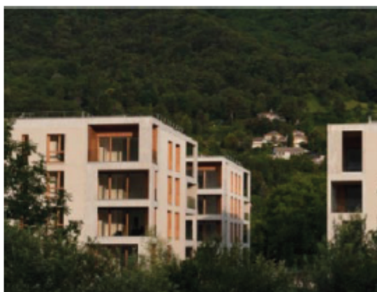
Principes d'implantation et de percées visuelles Image de référence - Brenas Doucerain, Seyssins
