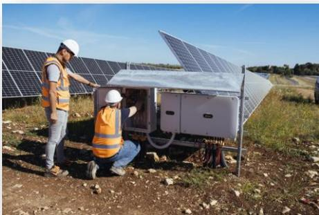
Figure 14 : Montage des onduleurs (European Energy)
