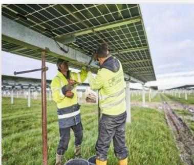
Figure 10 : Montage des trackers (source : European Energy)
