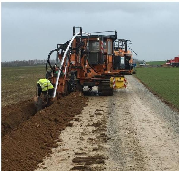
Figure 83 : Mise en place d'une liaison souterraine HTA (source : elec-enr.com)
