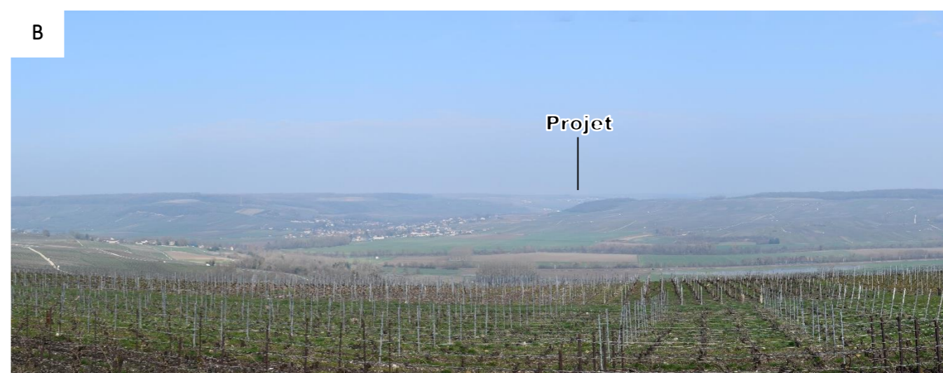
Figure 50 : Depuis le haut des coteaux de Bouquigny (Vallée de la Marne). Le projet n'est pas perceptible en raison de la grande distance (11.7 km) (@ATER Environnement, 2024)
