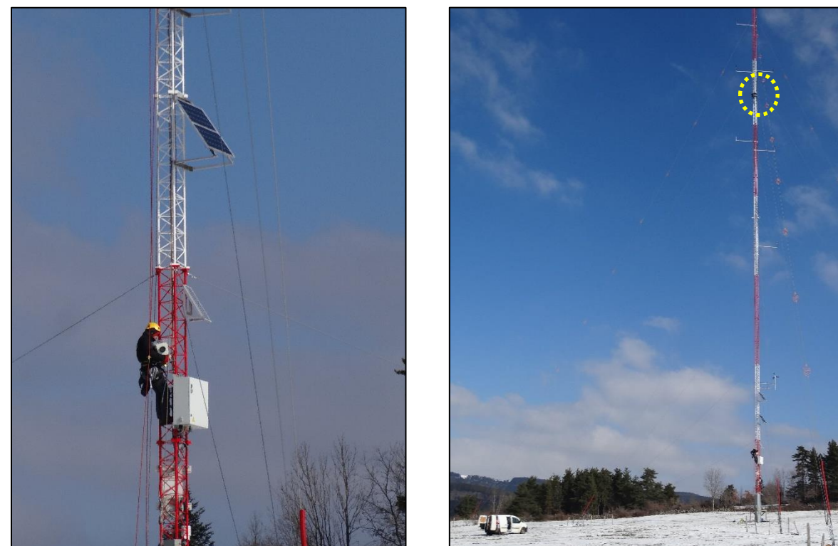
Figure 3 : Modules Batcorder autonome du Batcorder installés sur un mât de mesure (cliché de droite)
