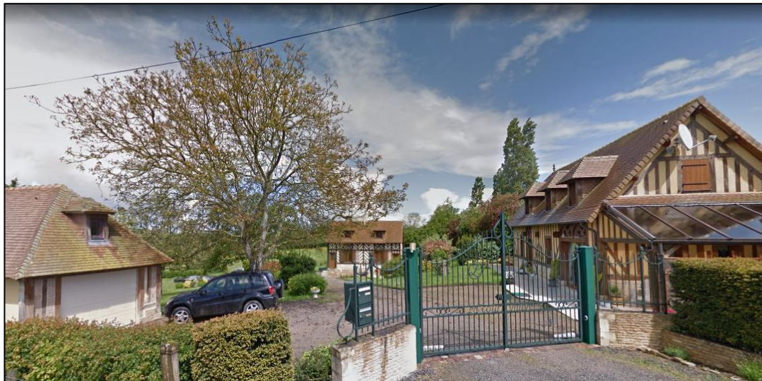
Maison construite dans le style néo- normand dans la commune de Saint-Samson (via google streetview)
