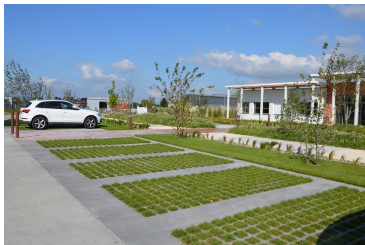
Exemple de parking végétalisé
