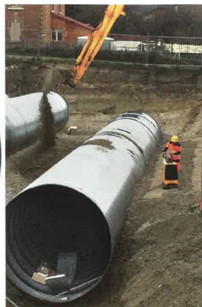
Compactage par couches symétriques de 30 cm
