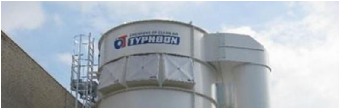
Exemple de panneaux soufflables sur un dépoussiéreur
