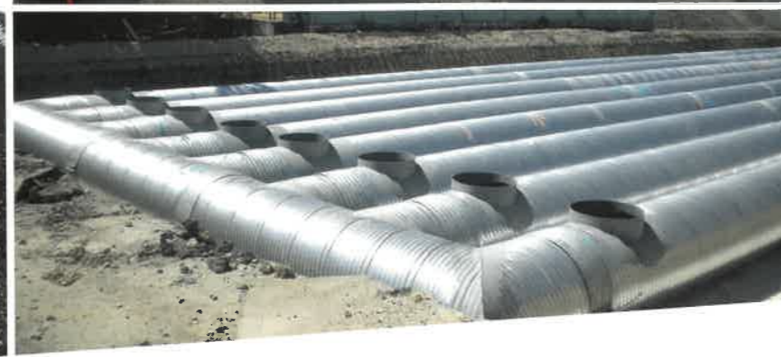
Nourrice du même diamètre que le réservoir = répartition hydraulique parfaite
