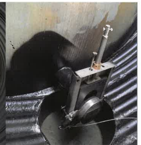
vortex et vanne intégrée
