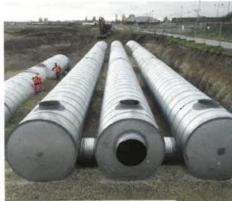
Piquage d'entrée et communication Ø1000 en SPIREL® à raccorder par collier
