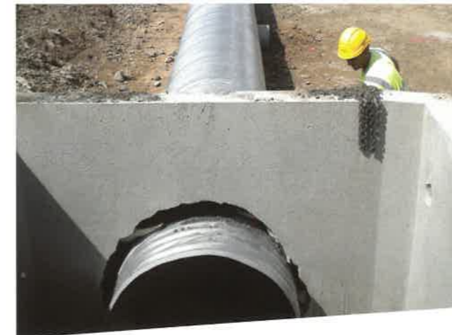
Raccordement collecteur tous type de matériaux fournis à la livraison
