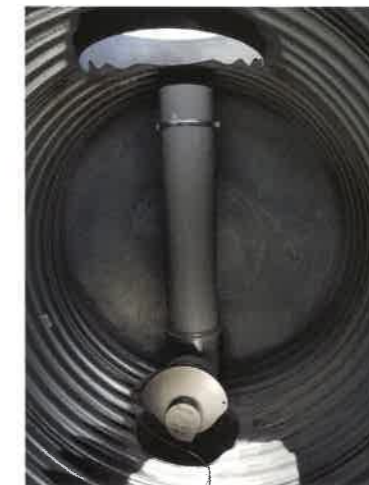
Vortex et surverse intégrée
