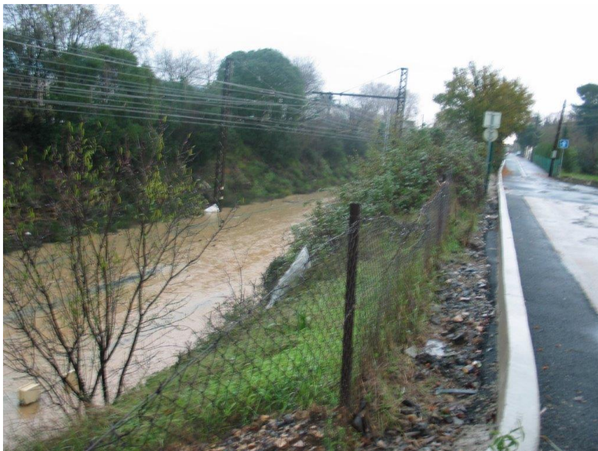
SABLAUSSOU : Inondation de la voie ferrée Mars 2011 après une remontée de nappe
