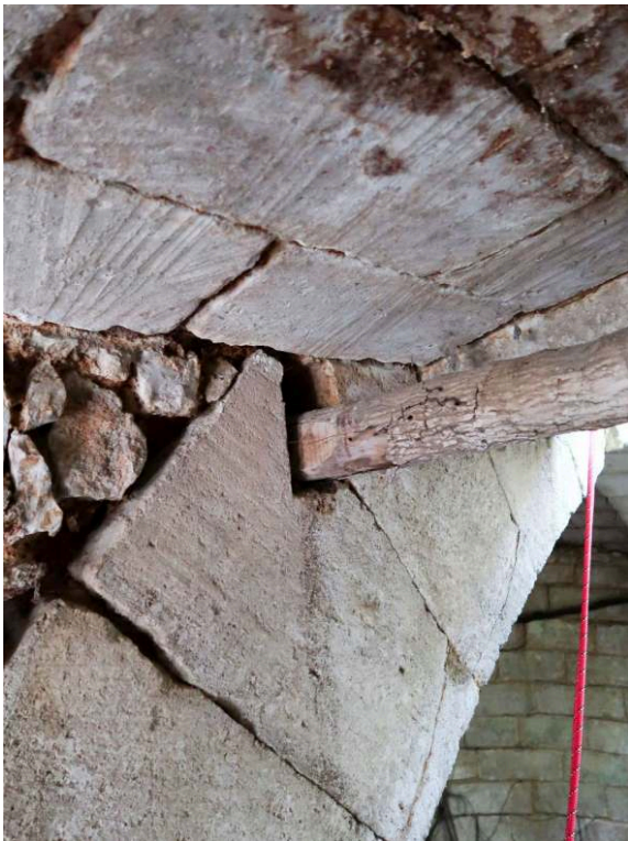
Castelnau-le-Lez (Hérault) ; le passage voûté, empochement sud pour une poulie. © V. Rousset
