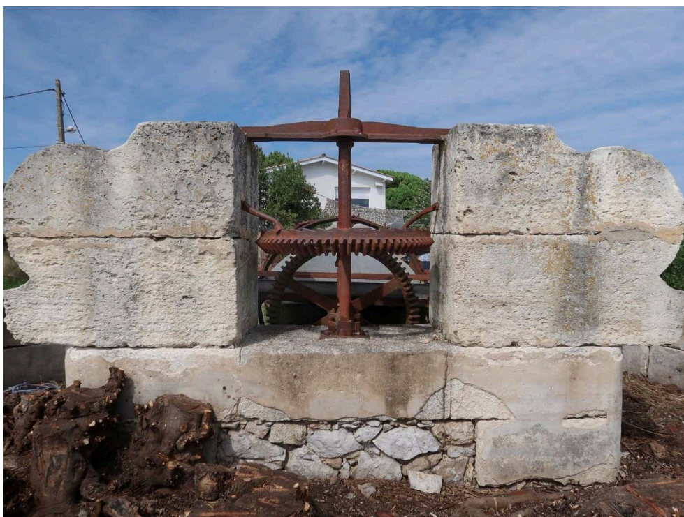
Castelnau-le-Lez (Hérault) ; la margelle et la potence en pierre vues du sud. Maçonnerie moellonnée et en pierre de taille. © V. Rousset
