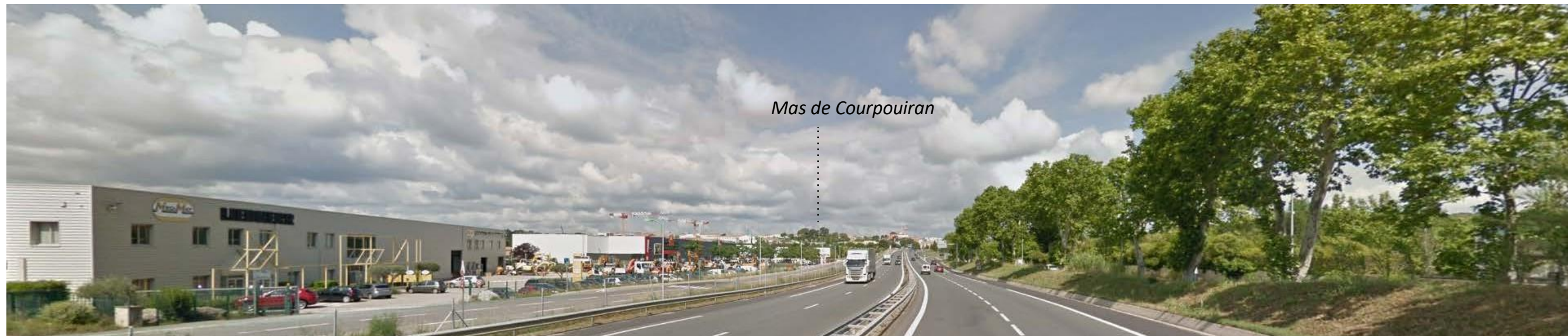
29 - Cadrage de la vue par l'alignement de platanes à droite, impact de la zone d'activités sans traitement de ses franges à gauche, boisements du mas de Courpouran en point focal.
