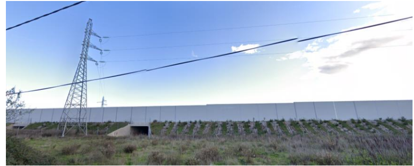
Le talus de l'A9 et ses panneaux anti-bruit
