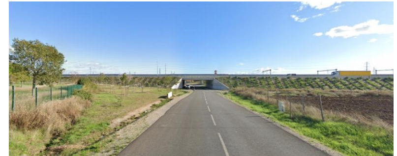
Le franchissement de l'A9 par le chemin de Raffegan, à l'est du site
