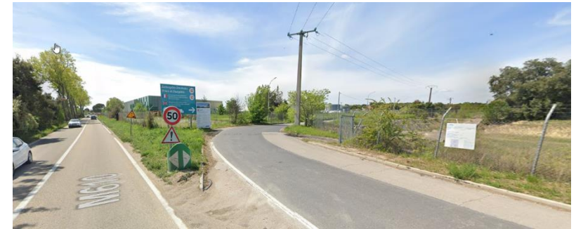
L'accès principal au site du projet depuis la RM610
