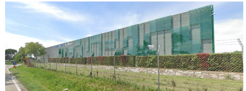
Principal bâtiment de la plate-forme logistique
