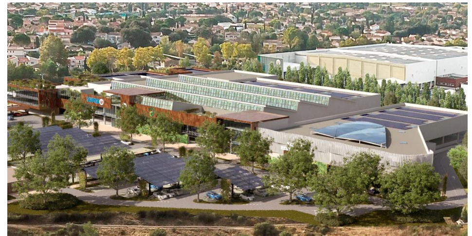
Vues des façades du projet, côté RM610 et côté nord (source : BETAC, architecte)
