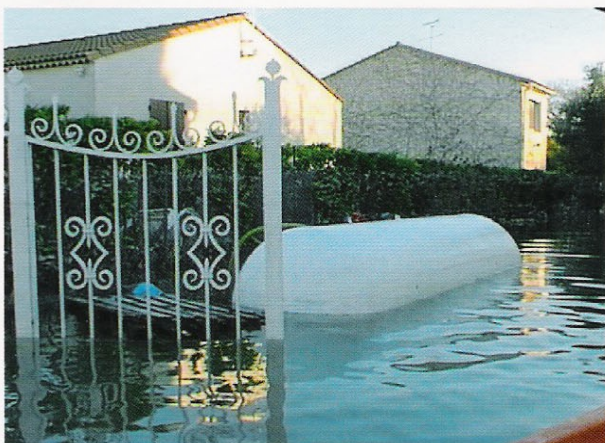
Cuve soulevée par l'eau.
