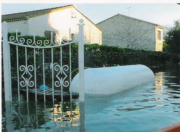
Cuve soulevée par l'eau.
