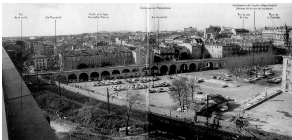
1973 le viaduc du chemin de fer de Palavas vu depuis la nouvelle mairie.
