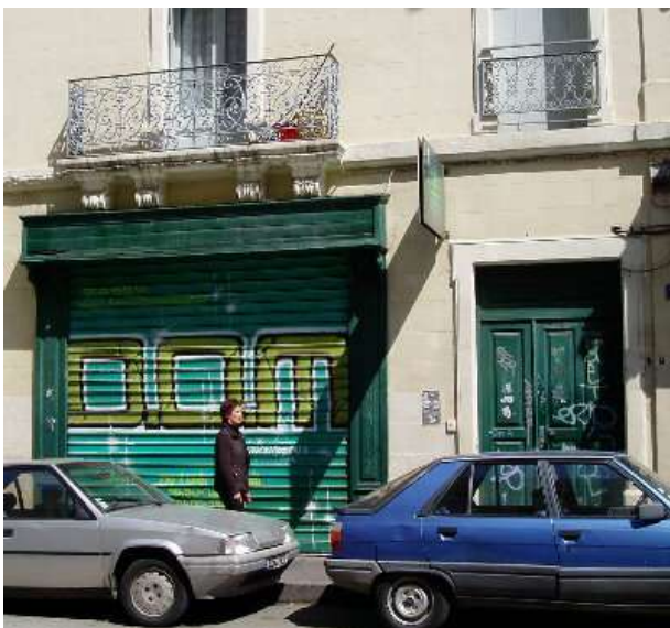
31 rue de Verdun Devanture en bois posée en applique sur la façade.
