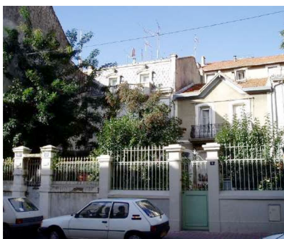
Maisons en bande 8, 10 rue Peyson
