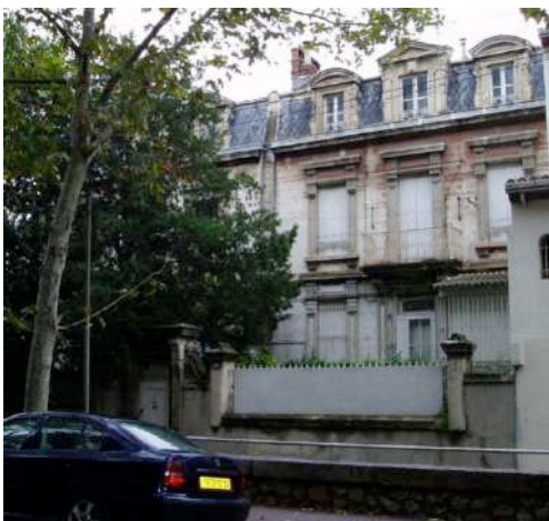
Maisons 17,19 avenue du Pont Juvénal
