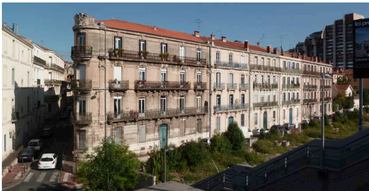
Façades de la rue Du Guesclin vue depuis l'avenue Henri Frenay, avant urbanisation de la zone de projet et création d'un nouveau front bâti.
