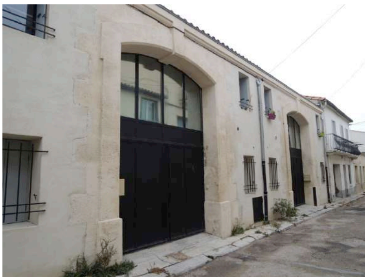
Restructuration de remises
