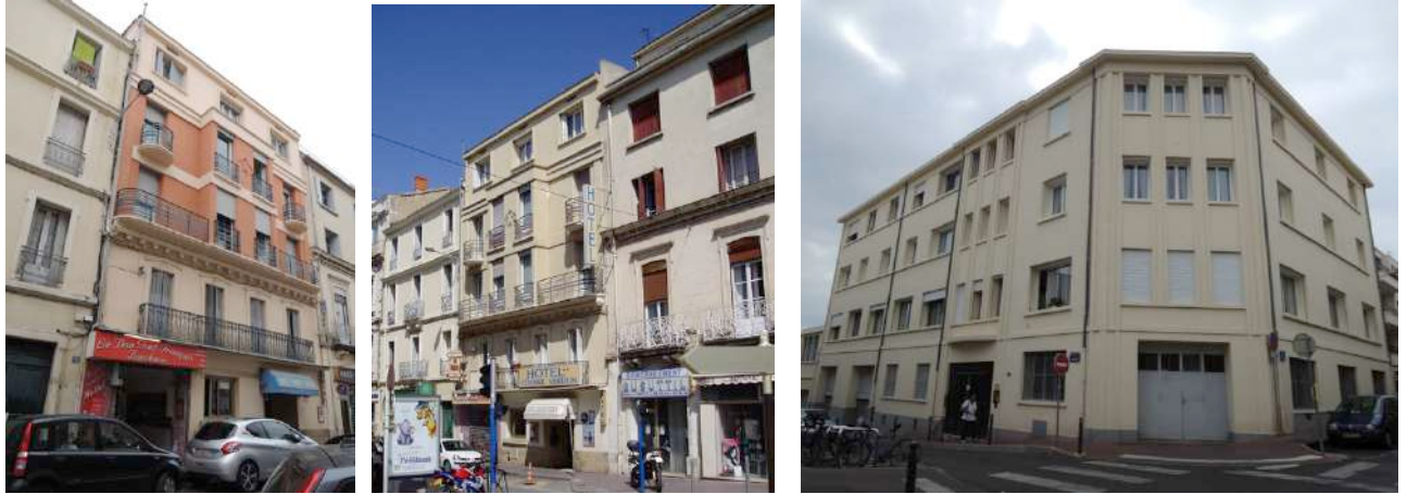
Le remplacement ou la modification de surfaces de façades ferait disparaître les matériaux d'origine, la modénature et la composition qui caractérisent ce type de bâtiments.
