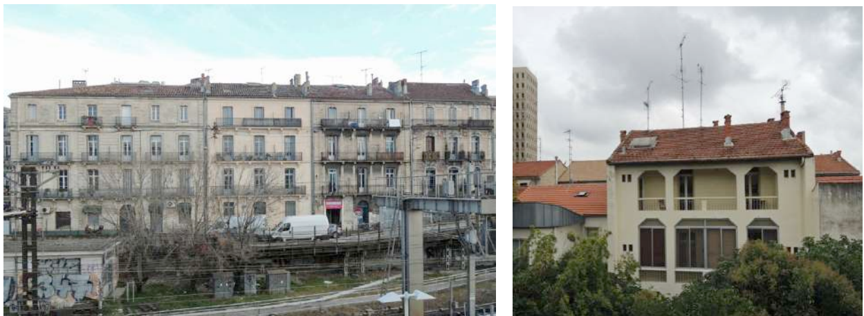
Le remplacement ou la modification de surfaces de toitures par des surfaces de capteurs ferait disparaître les matériaux d'origine, la modénature et la composition qui caractérisent ce type de bâtiments, de plus en leur substituant des matériaux récents dont on ne connaît pas réellement la durabilité et la capacité d'intégration.
