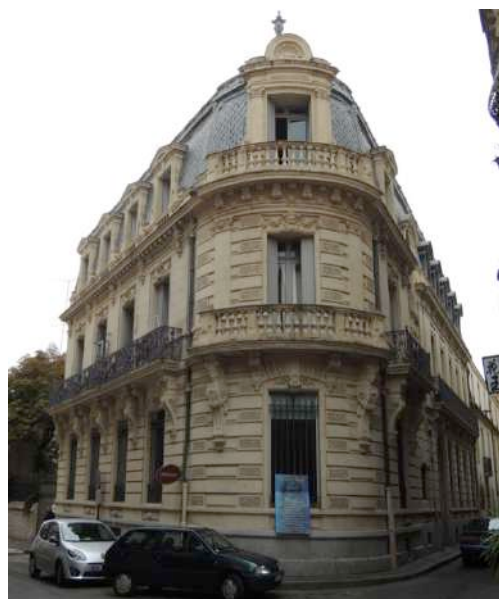
Maison rue Boussairolles
