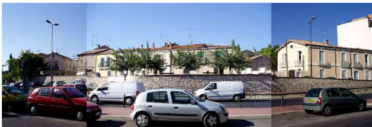
Façades et mur en pierre du quai Laffite
