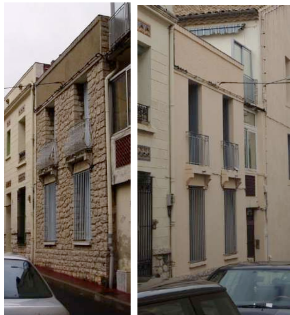
27 rue Isidore Girard Avant et après ravalement Les moellons ont été enduits
