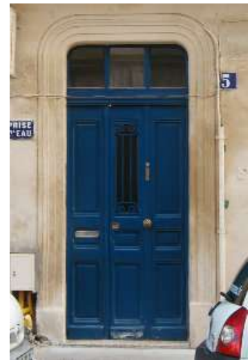
rue du Pont de Lattes
