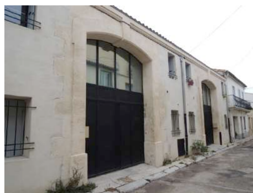
Hangar réhabilité rue de Constantine
