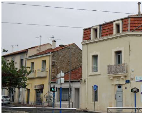
La mise en place d'une ITE sur certains murs pignons est parfois envisageable selon la modénature et la possibilité de faire disparaître les rives techniques latérales et hautes
