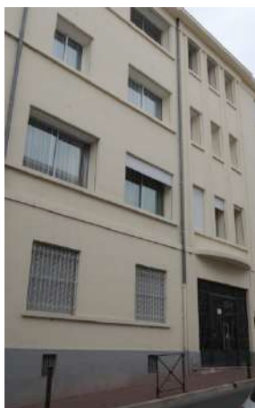
Il est souhaitable d'utiliser les dispositions existantes, ou de les retrouver, par exemple avec des grilles de ventilation harmonisées à la façade.
