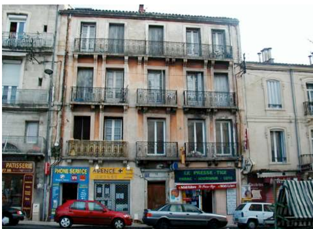
Le remplacement de la fenêtre par un modèle hétérogène nuit à l'harmonie d'origine.
