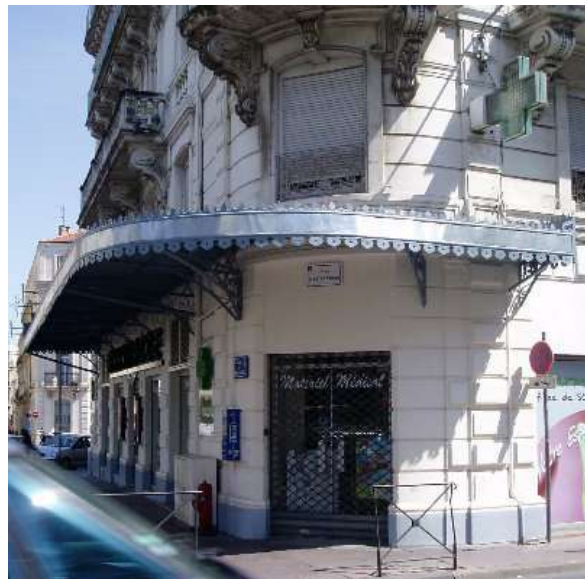
2 rue Frédéric Bazille Marquise métallique
