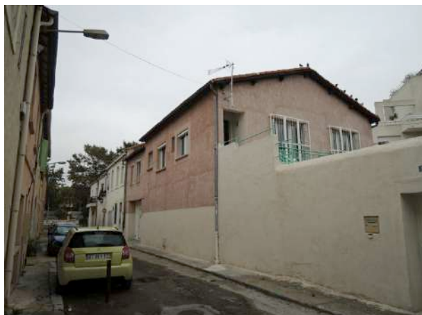
La mise en place d'une ITE est parfois envisageable, en prenant en compte le caractère du bâtiment et sa nouvelle insertion urbaine, tout en préservant les modénatures existantes
