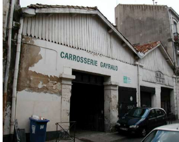
Hangar 15,17 rue Louis Figuiet
