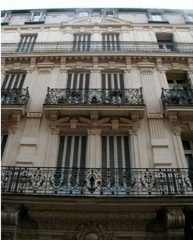
19 rue de Verdun Détail de fond de façade en pierre de taille
