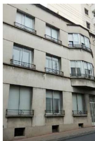
Il est souhaitable d'utiliser les dispositions existantes, ou de les retrouver, par exemple avec des grilles de ventilation harmonisées à la façade.
