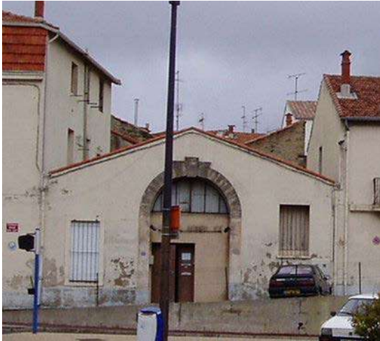
Hangar 51 rue Barcelone
