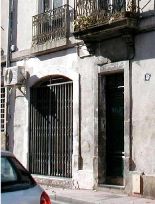
46 rue Henri René (ancienne remise...) Le climatiseur devrait être intégré dans la vitrine
