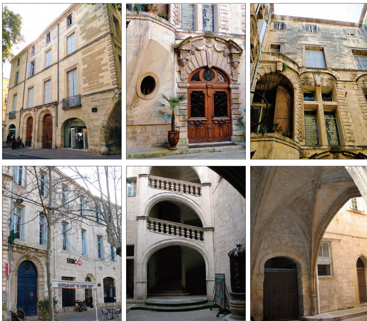
Les hôtels particuliers et la richesse architecturale dans les cours.
