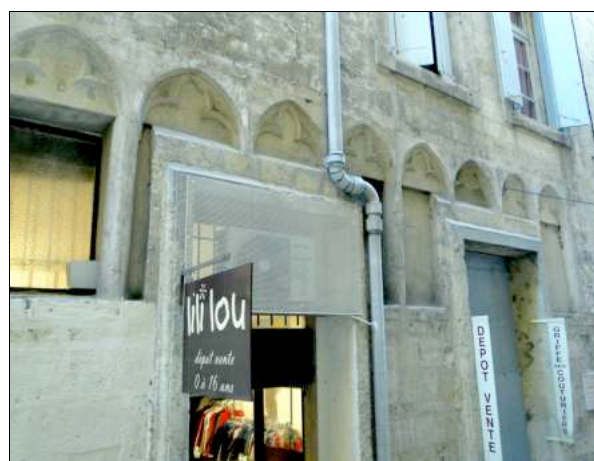
Fig. 10 Montpellier - 3, rue de l'Ancien Courrier
