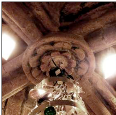
Fig. 49 - 10, rue En Gondeau
