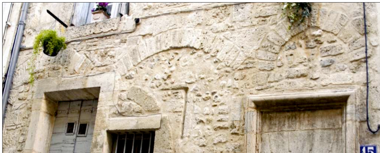
Fig. 22 15, rue de l'Ecole de Pharmacie — arcs de décharge d'anciennes baies sous linteau de bois
