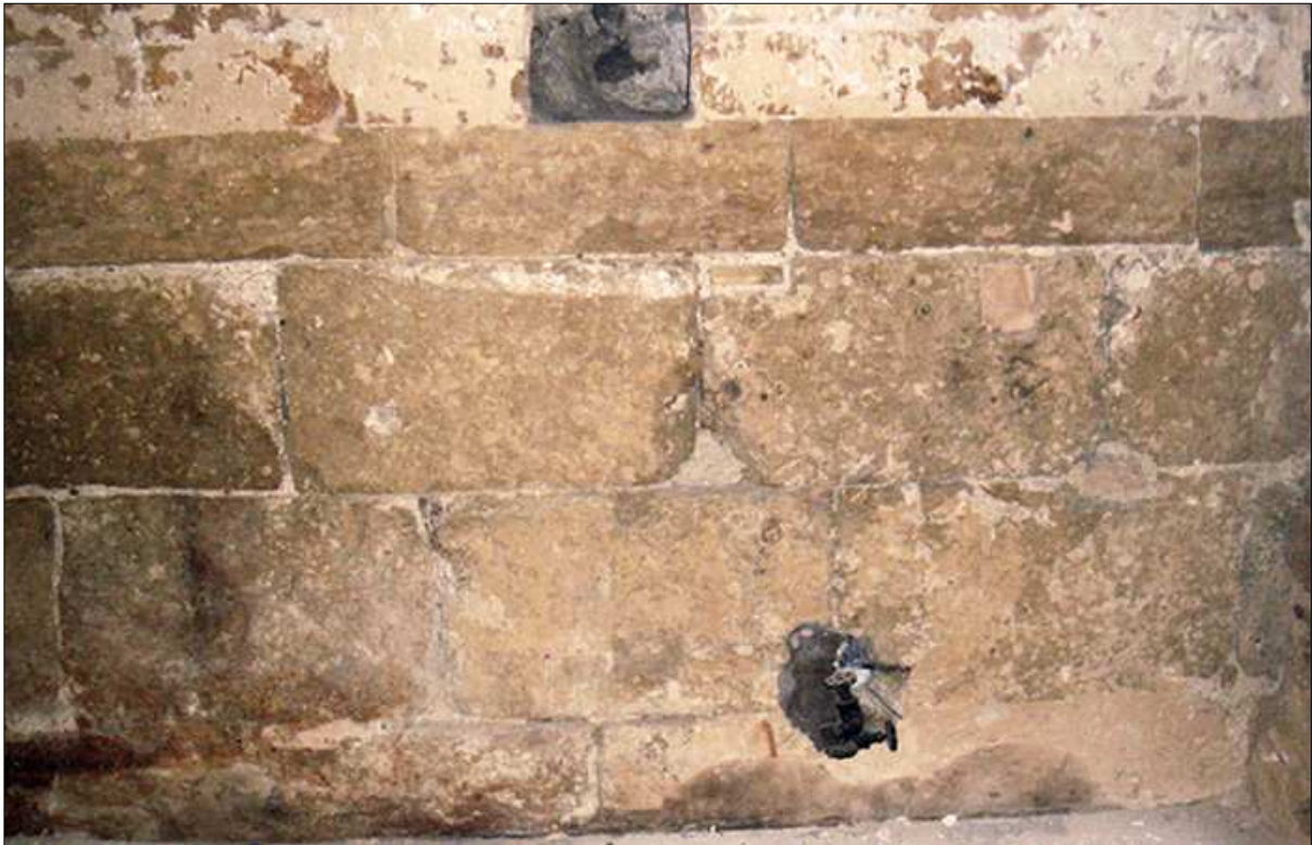
Vestige de la Clôture commune ( ? ) à l'hôtel de Bocaud
