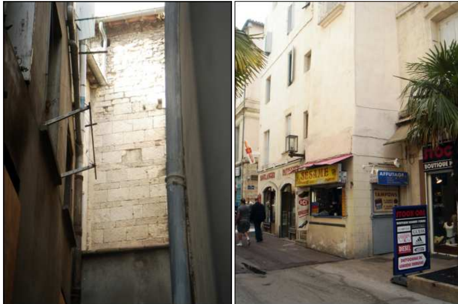
Elévations de la Clôture commune à l'impasse Vien et à la rue St-Guilhem
