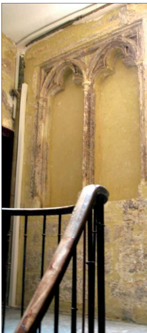
Fig. 62 10 rue du Plan d'Agde — vestiges d'une ancienne façade sur cour dans la cage d'escalier
