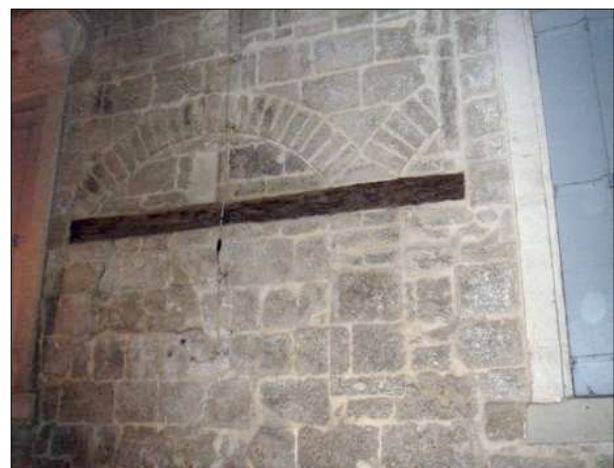
Fig. 6 : Montpellier - arcs de décharge et sablières filantes couvrant plusieurs baies par une seule pièce
