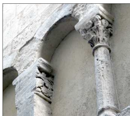
Fig. 17 4, rue Delpech — fenêtre triple avec ses deux chapiteaux sculptés et sa colonnette polygonale
