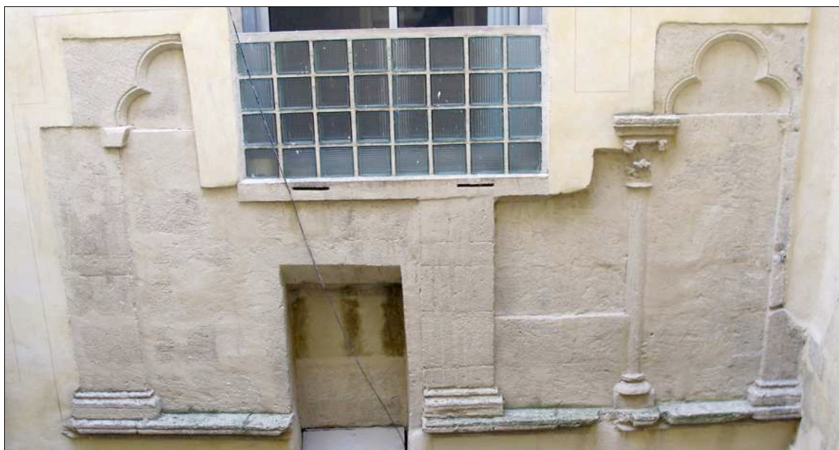
Fig. 32 9, rue de l'Ancien Courrier — baies médiévales de l'élévation sur cour
