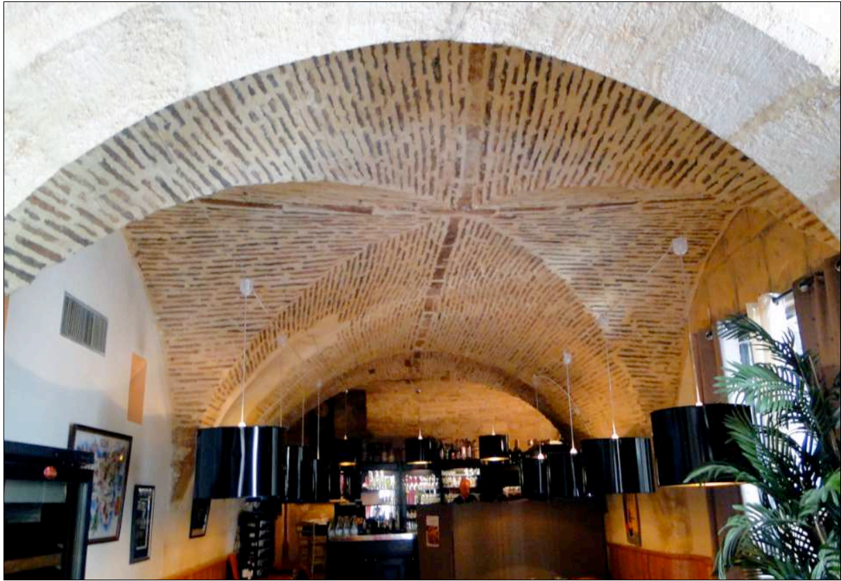
Fig.45 - 2, rue de la Préfecture
