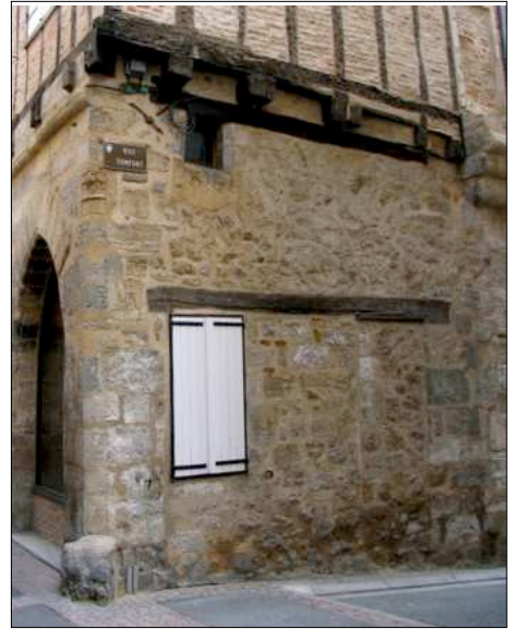
Fig. 3 : Figeac - boutique sous linteaux de bois
