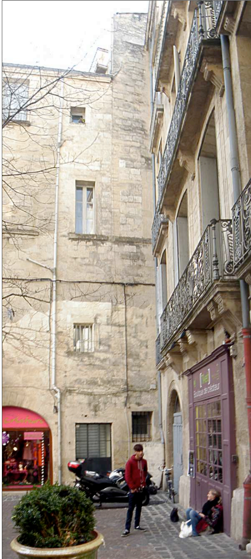
Au fond de la rue Glaize, la venelle prolongeant l'impasse Tour d'En Canet est occupée par le bâtiment qui émerge. Autrefois elle continuait vers le sud, « allant à Notre Dame ».
