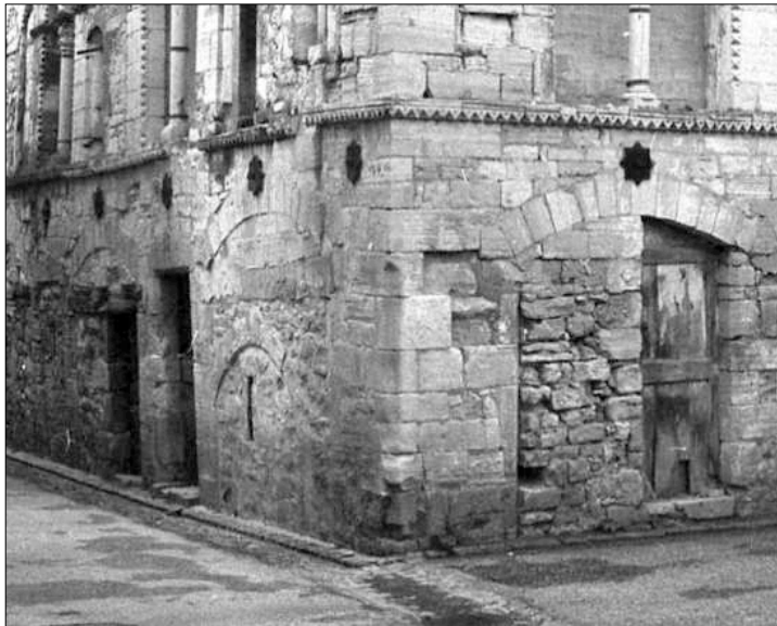
Fig. 2 : Villemagne-Largentière - boutiques sous linteaux de bois
