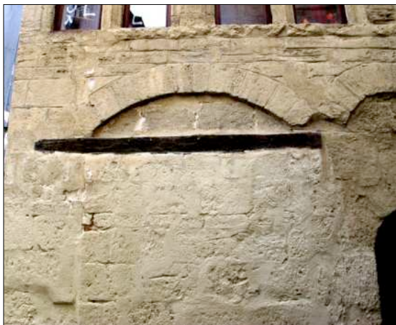
Fig. 6 : Montpellier - arcs de décharge et sablières filantes couvrant plusieurs baies par une seule pièce
