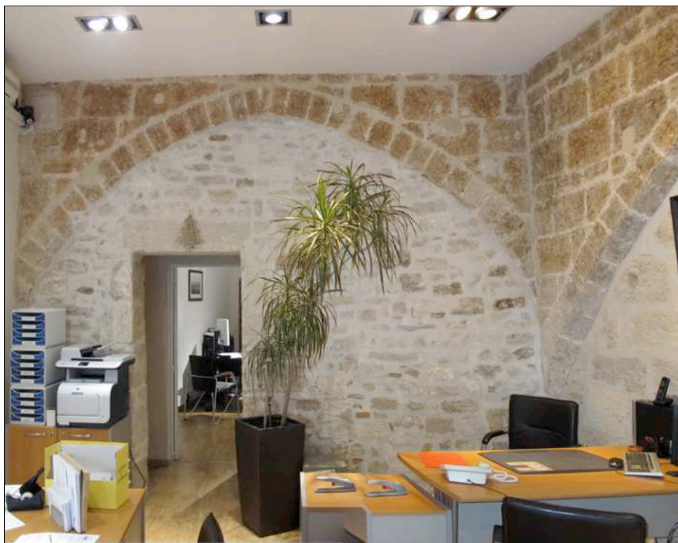
Fig. 44 10, rue de l'Université — deux arcades en arc brisé et une troisième arcade, perpendiculaire à la façade, divise le rez-de-chaussée en deux travées
