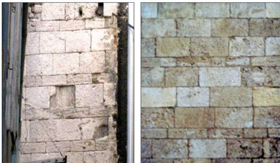
Fig. 1 «Appareil de Montpellier» : L'appareil alternant assises de parpaings traversants et de carreaux posés sur chant
