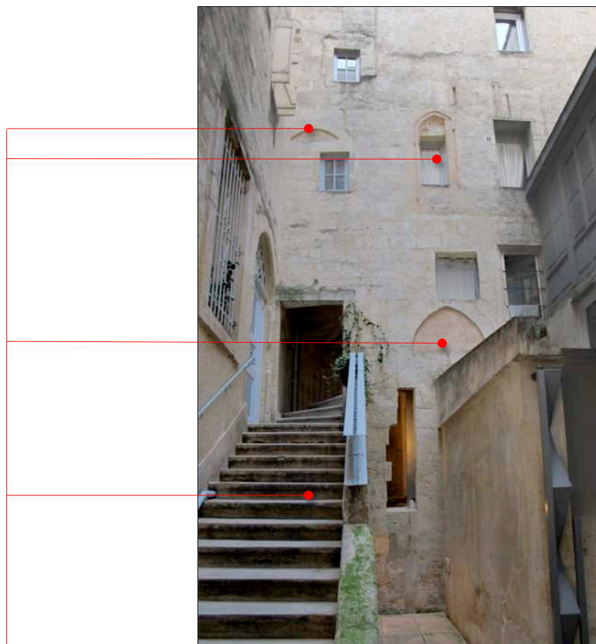
Fig.58 15, rue de l'Ancien-Courrier — escalier extérieur et des vestiges d'une des façades médiévales sur cour
