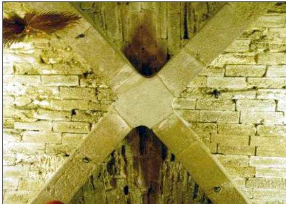
Fig. 21 - 2, rue des Trésoriers de France
