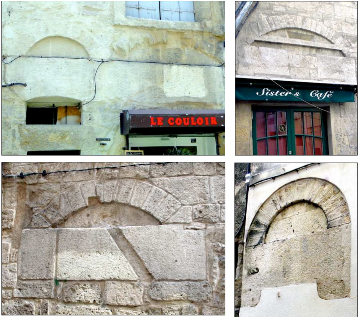
Fig. 7 : Montpellier - linteaux de pierre monumentaux surmontés par des tympana sous arc de décharge.
