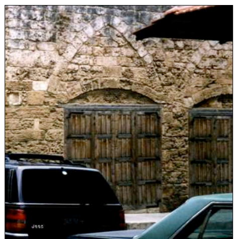
Fig. 5 : Liban - boutiques sous linteaux de bois
