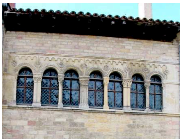
Fig. 9 Cluny - fenêtrage disposées en claires-voies
