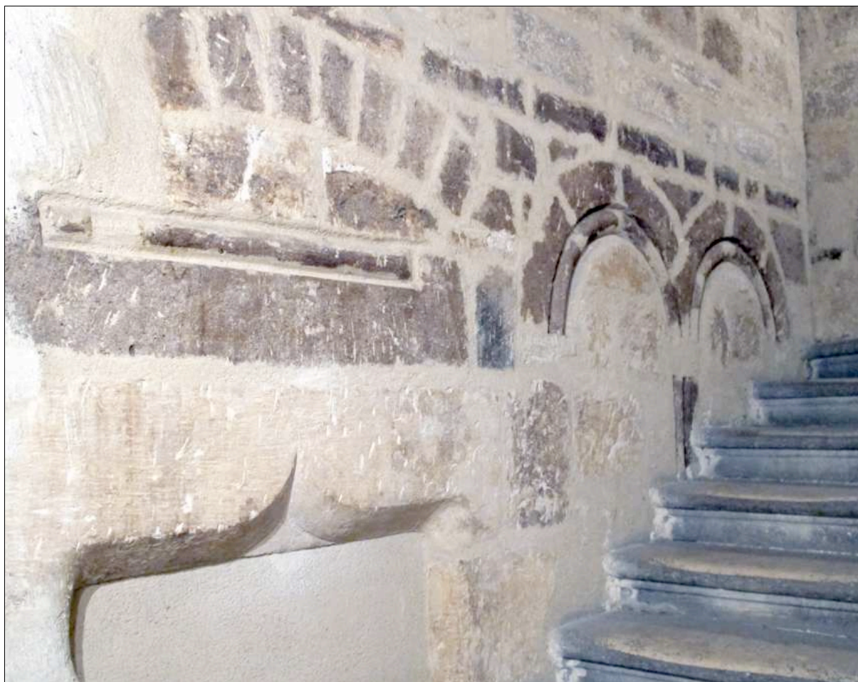
Fig. 30 25, rue de l'Aiguillerie — vestiges d'une fenêtre géminée et d'une porte à linteau mouluré (retourné) dans la cage d'escalier
