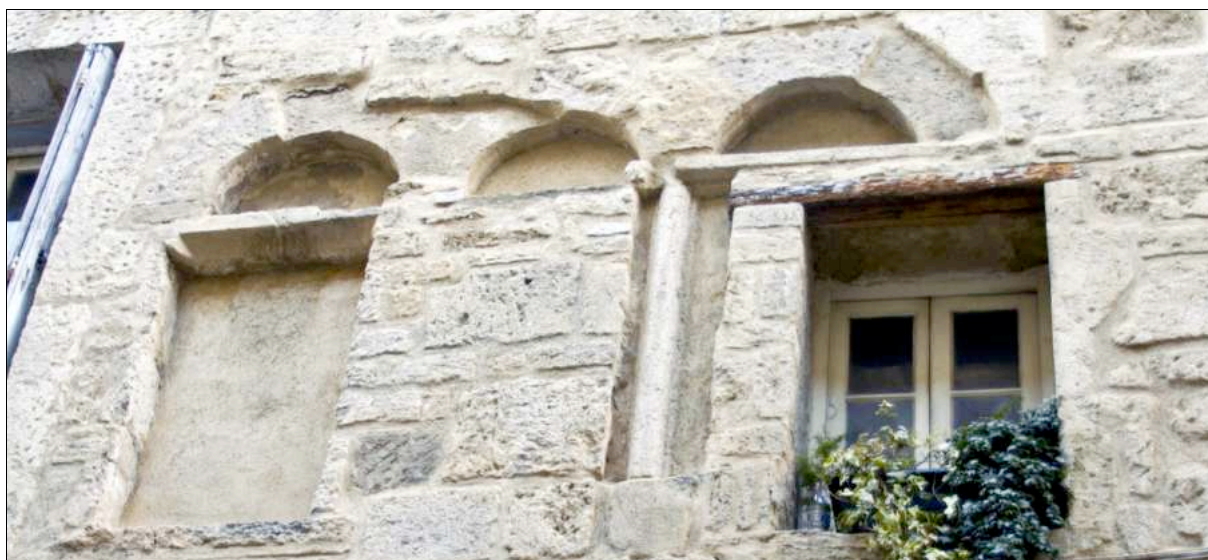
Fig. 21 15, rue de l'Ecole de Pharmacie — fenêtre triple à formes en plein cintre clavé, (la colonnette de droite est rapportée)
