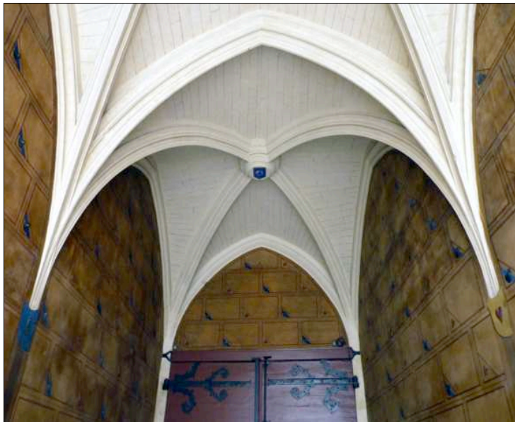
Fig. 37 - 5, rue des Trésoriers de France
