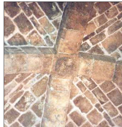
Fig. 25 - St-Jean d'Acre, Refectorium
