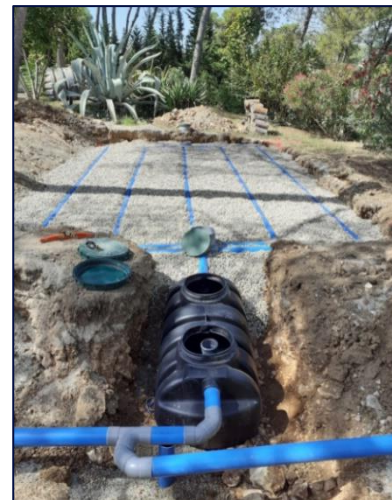
Système ANC en travaux
