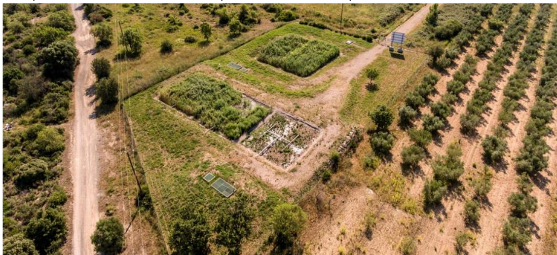
Figure 4 : Station d'épuration de Cournonsec – Mas Plagnol / Bonnel
