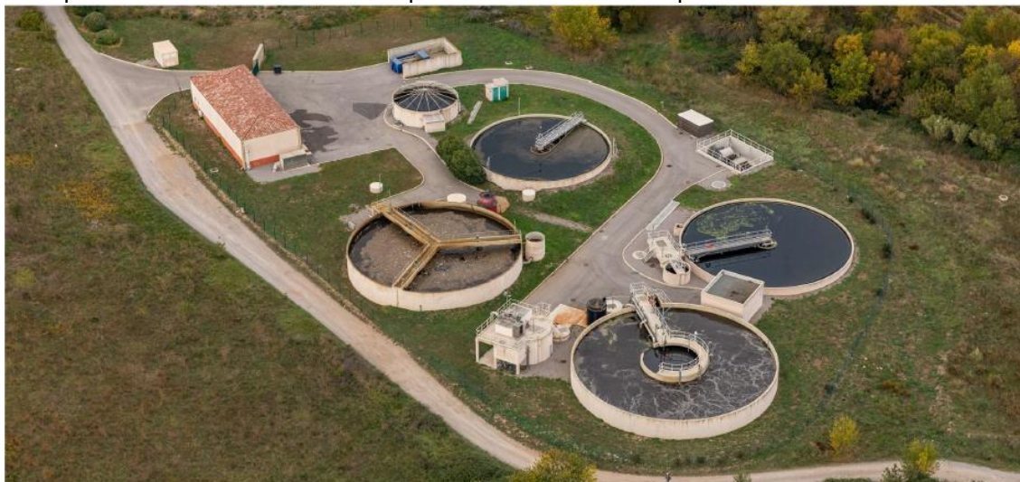
Figure 2 : Station d'épuration de Cournonsec-Cournonterral
